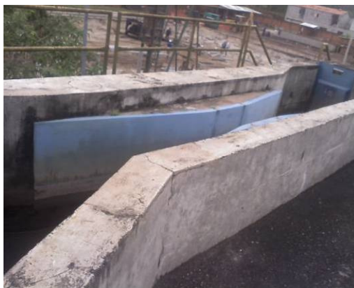
Fotografia 26 - Antiga calha Parshall com uma das comportas manuais dos tanques ao fundo Fonte: Autoria própria.
