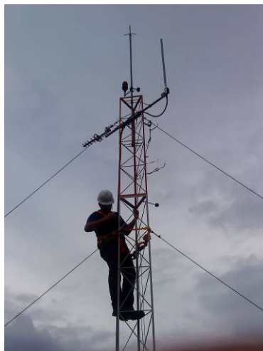
Fotografia 40 - Instalação do mastro e antenas dos rádios concentradores no CCR Fonte: Autoria própria.
