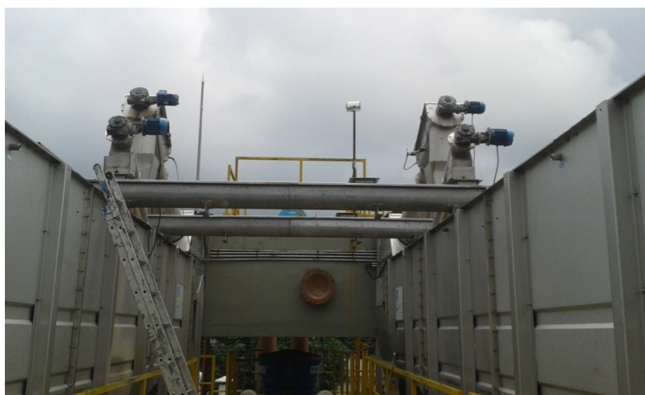
Fotografia 1 - Vista frontal dos dois conjuntos que compõem o pré-tratamento do afluyente Fonte: Autoria própria.
