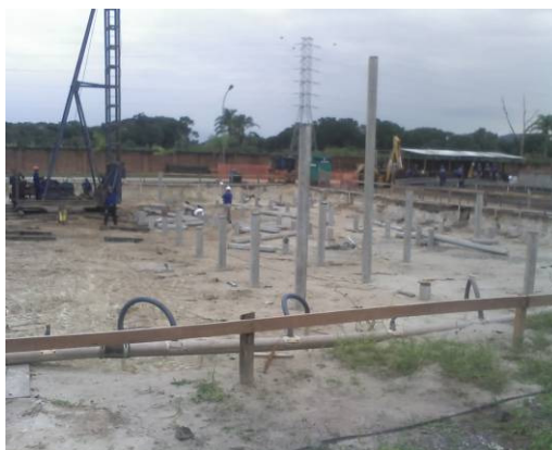
Fotografia 29 - Estaqueamento estrutural e rebaixamento de lençol freático sendo realizados para o tanque 4.3 Fonte: Autoria própria.
