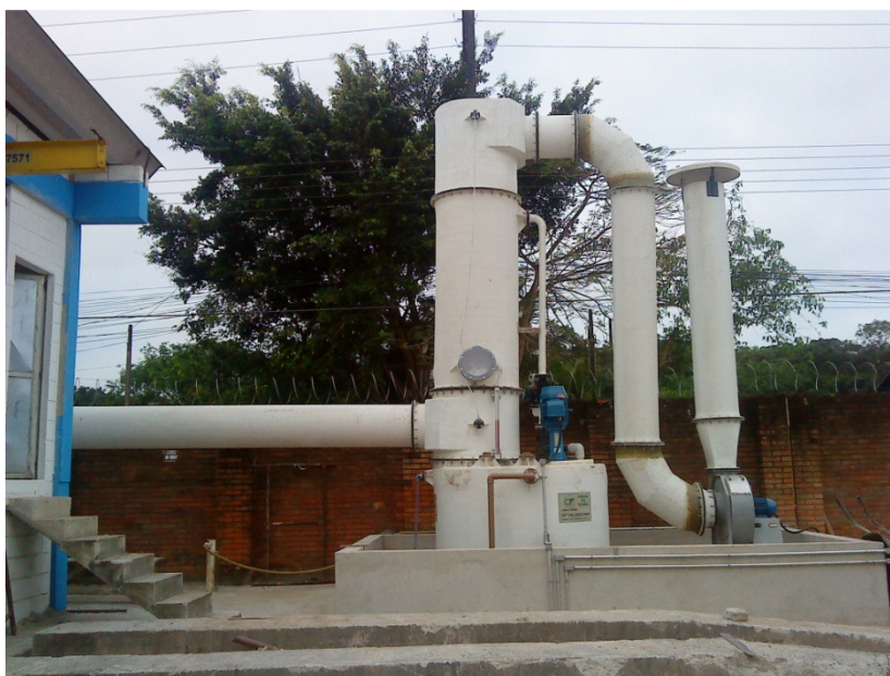
Fotografia 22 - Neutralizador de gás cloro Fonte: Autoria própria.
