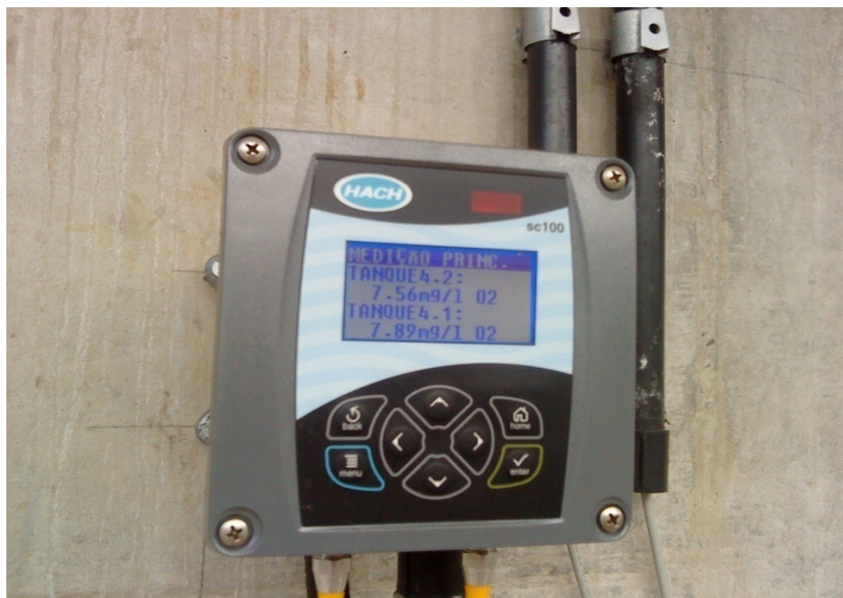
Fotografia 10 - Eletrônica do analisador de oxigênio dissolvido dos tanques 4.1 e 4.2 Fonte: Autoria própria.
