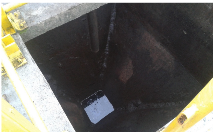
Fotografia 17 - Vista interna do Adensador 03 Fonte: Autoria própria.
