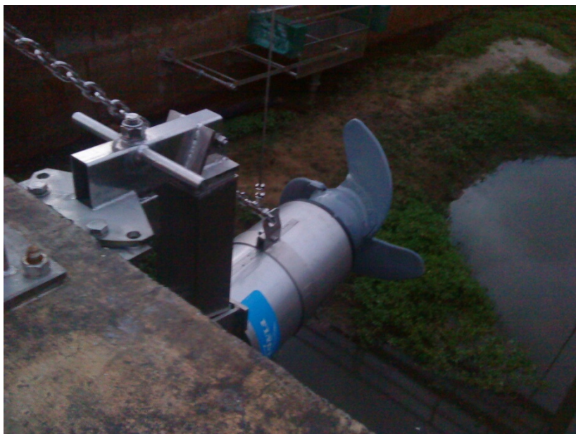
Fotografia 11 - Misturador MIX-4.2A com visto do fundo do tanque 4.2 assoreado Fonte: Autoria própria.
