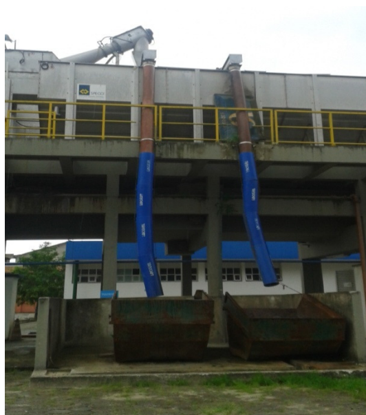
Fotografia 2 - Vista lateral do pré-tratamento. A caçamba do lado esquerdo recebe os sólidos grosseiros e a do direito, areia Fonte: Autoria própria.
