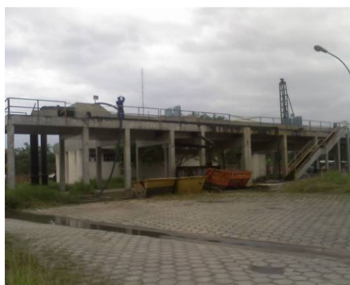
Fotografia 25 - Vista lateral do antigo pré-tratamento da ETE- Bertioga Fonte: Autoria própria.
