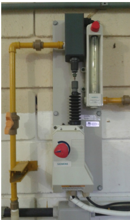
Fotografia 21 - Dosador de cloro DSL-01 Fonte: Autoria própria.
