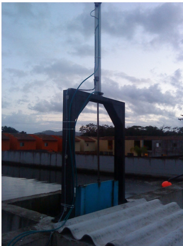
Fotografia 7 - Comporta de entrada VEP- 06 do tanque 4.4 Fonte: Autoria própria.
