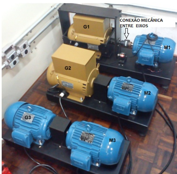
Figura 27 – Motores e Geradores Fonte: Própria
