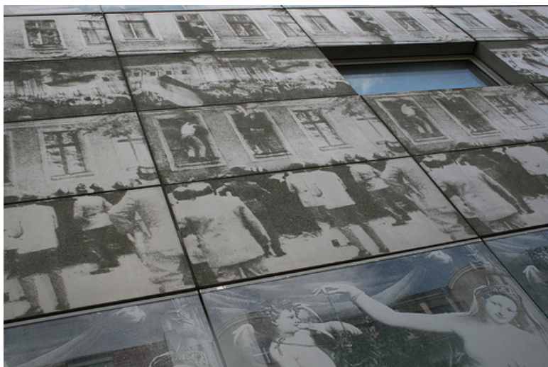
Figura 23 - Blocos de concreto impressos sobre a fachada.
