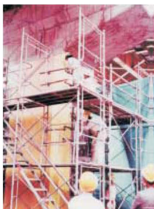
Aplicação da fibra de Kevlar em toda a seção de um pilar de uma ponte.
