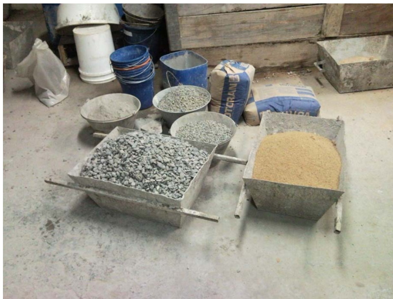
Figura 21 – Materiais dosados antes do preparo do concreto
