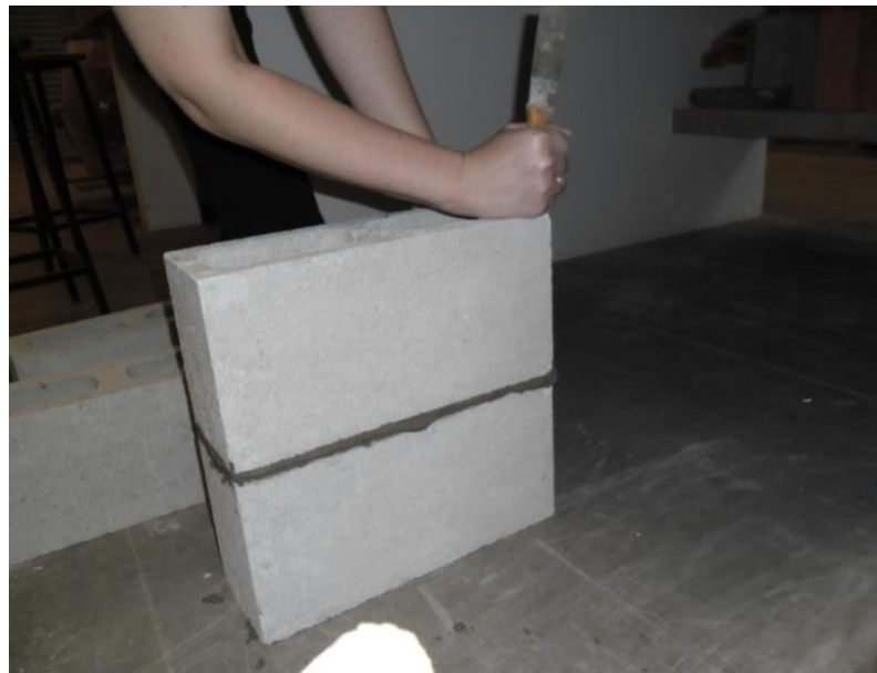
Figura 13 - - Assentamento do prisma ACI
