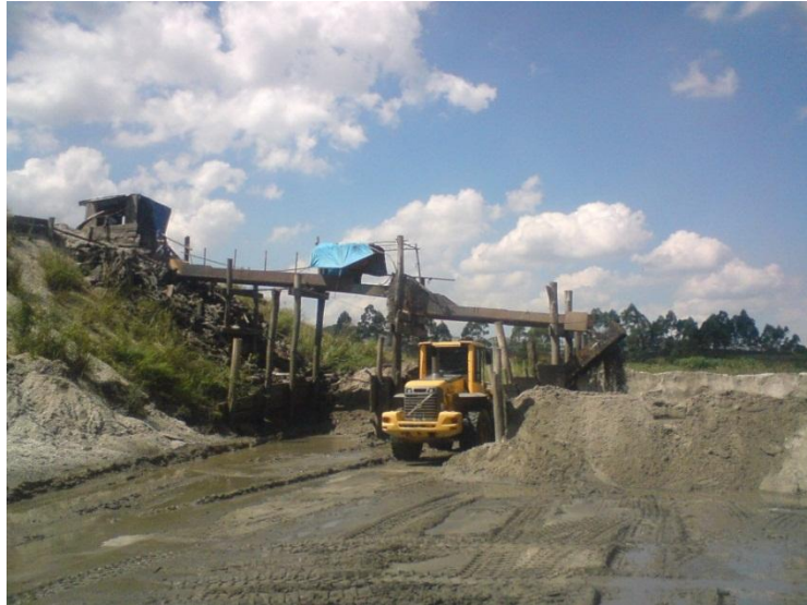
Figura 2.2 – Peneiramento da areia em grelhas fixas
