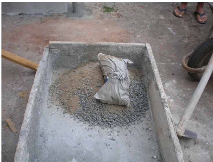
Figuras 4 e 5 – Agregados e cimento do concreto ensacado
