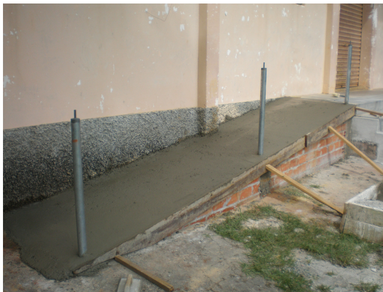
Figura 14 – Concretagem da rampa Fonte: PRÓPRIA, 2011.
