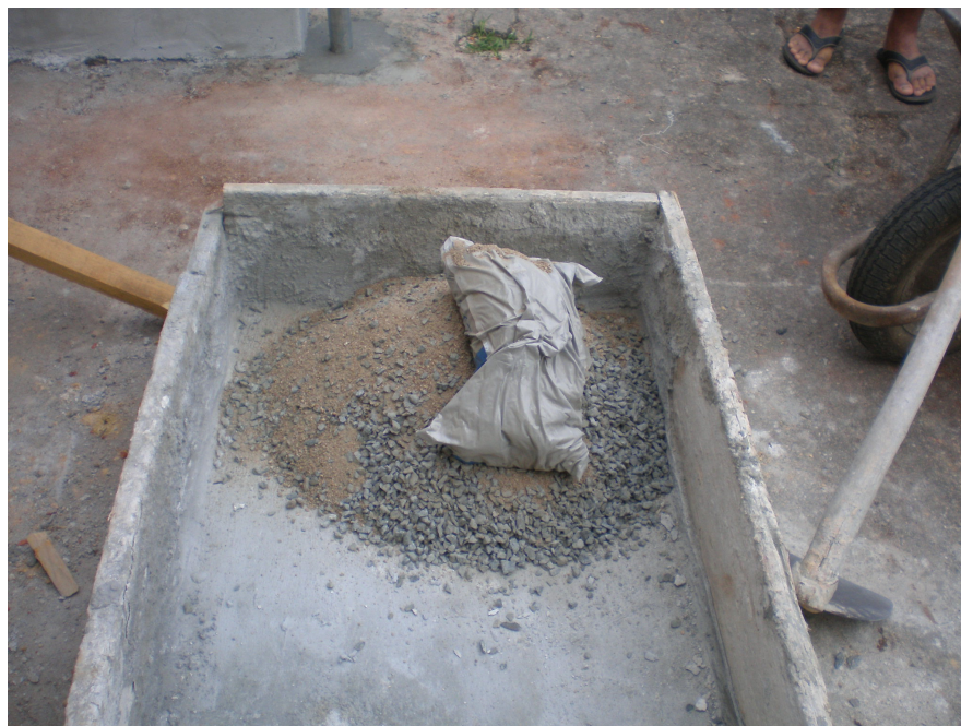
Figura 11 – Mistura dos agregados e do cimento do concreto ensacado Fonte: PRÓPRIA, 2011.
