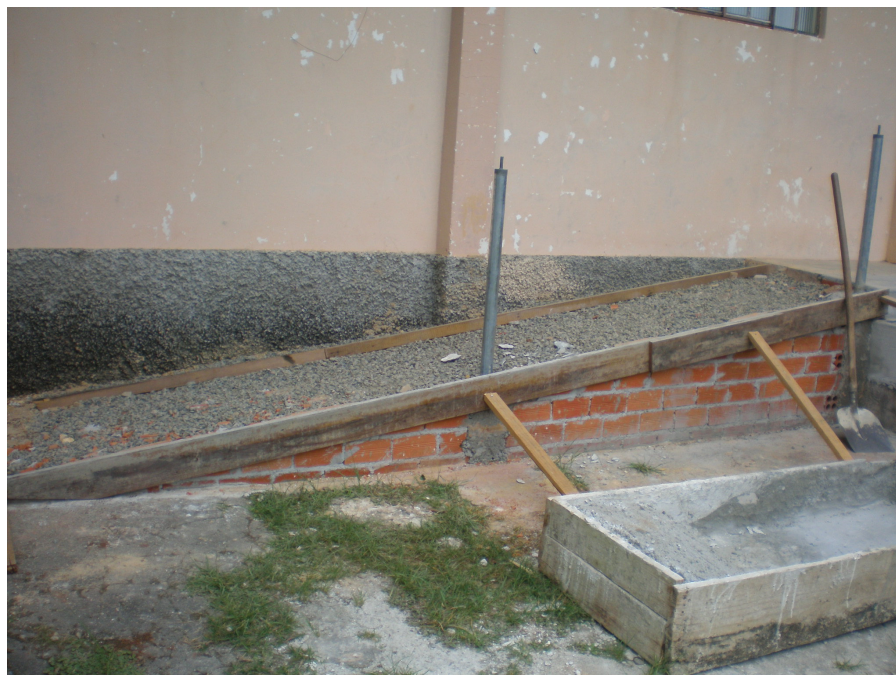
Figura 10 – Preparação da rampa para concretagem Fonte: PRÓPRIA, 2011.
