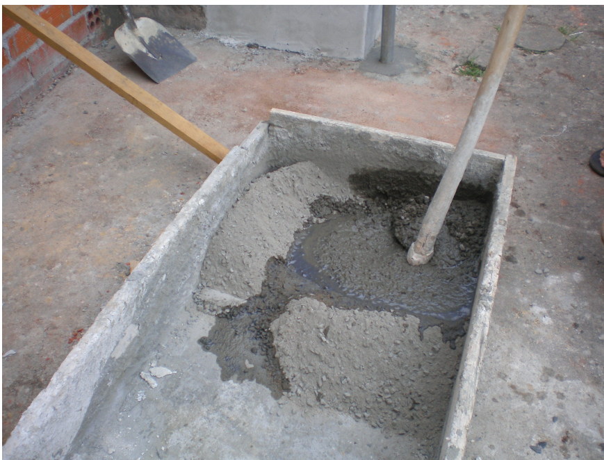
Figura 12 – Adição de água e preparo manual do concreto ensacado Fonte: PRÓPRIA, 2011.
