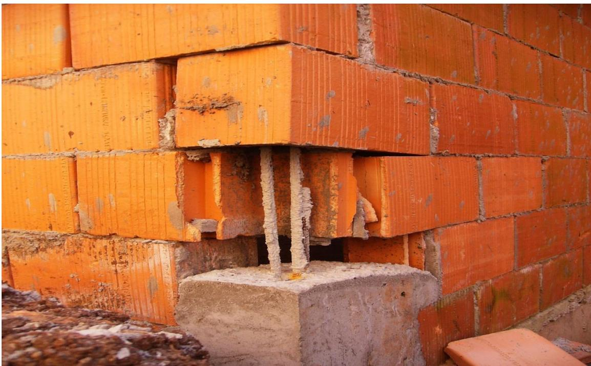
Figura 10- Ponto de graute falho, paginação mal distribuída. Fonte (canteiro de obras).
