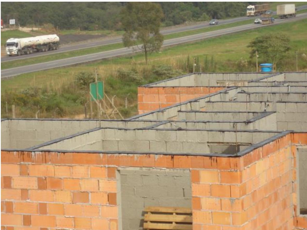
Figura 17- Execução de juntas de dilatação da laje de cobertura. Fonte (canteiro de obras).
