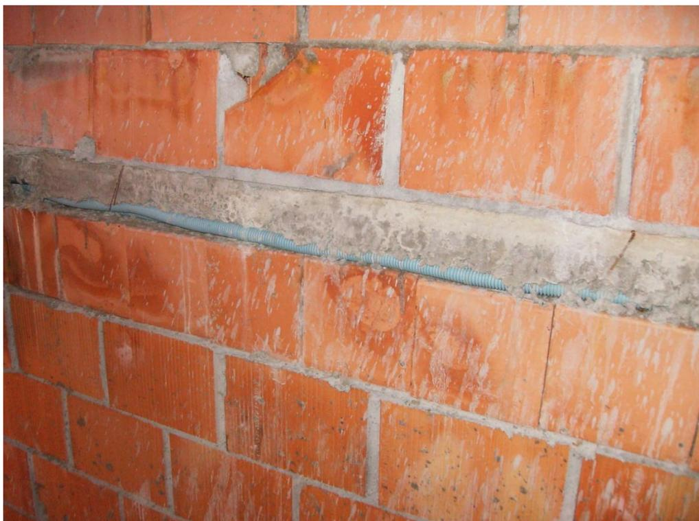
Figura 04- Argamassa de assentamento. Fonte (canteiro de obras).
