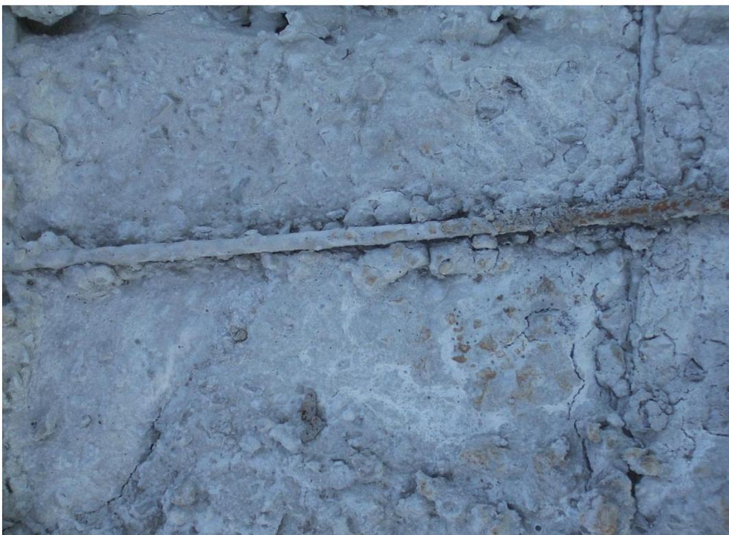
Figura 03- Exposição da armadura a intempérie. Fonte (canteiro de obras).
