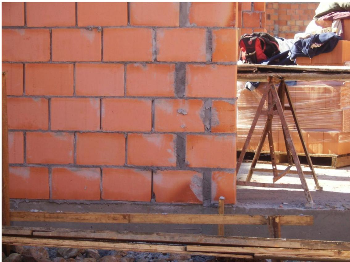
Figura 05- Juntas de assentamento não uniforme. Fonte (canteiro de obras).
