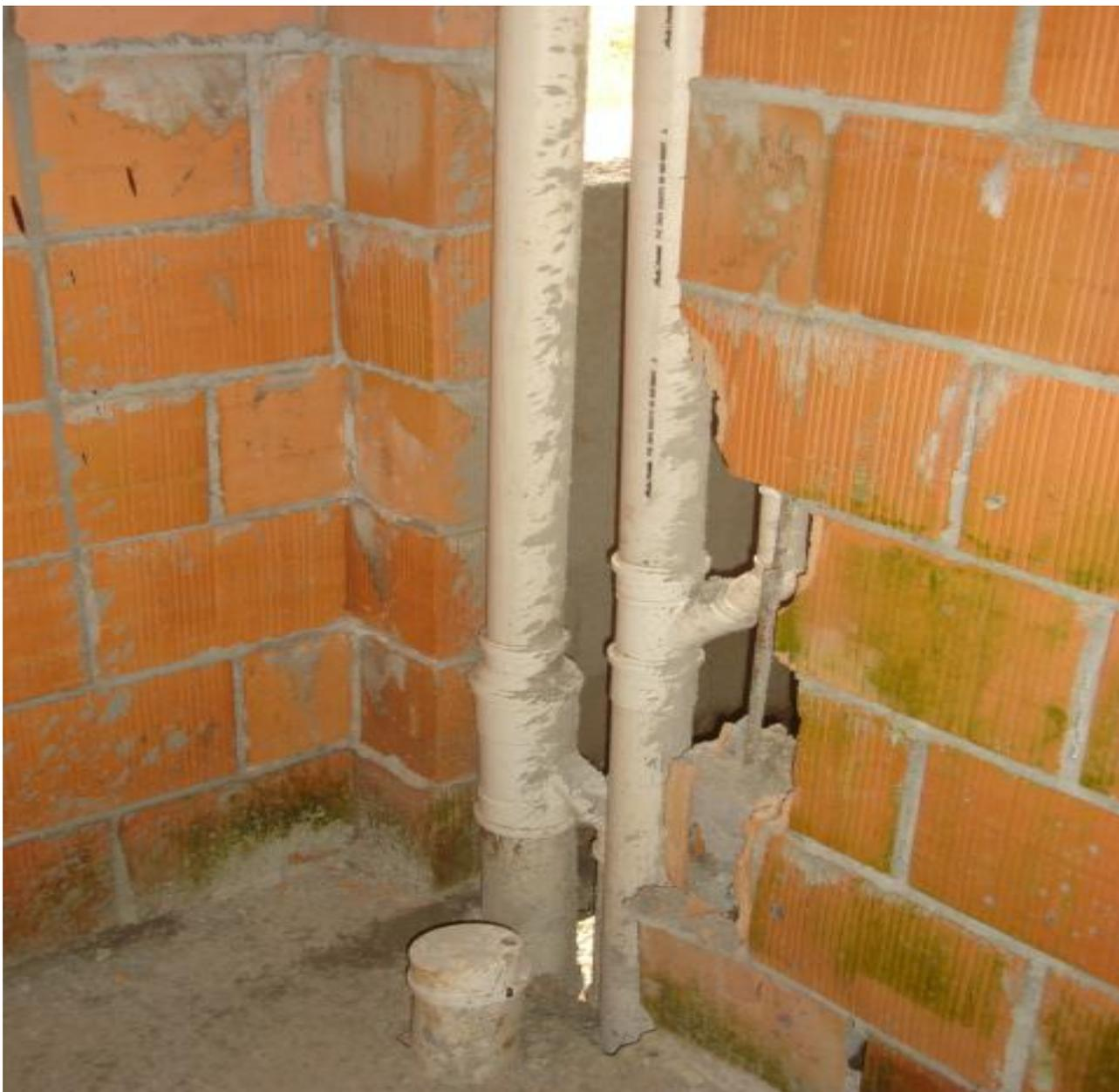
Figura 08- Embutimento de tubulações de esgoto, elaborado de forma incorreta. Fonte (canteiro de obra).
