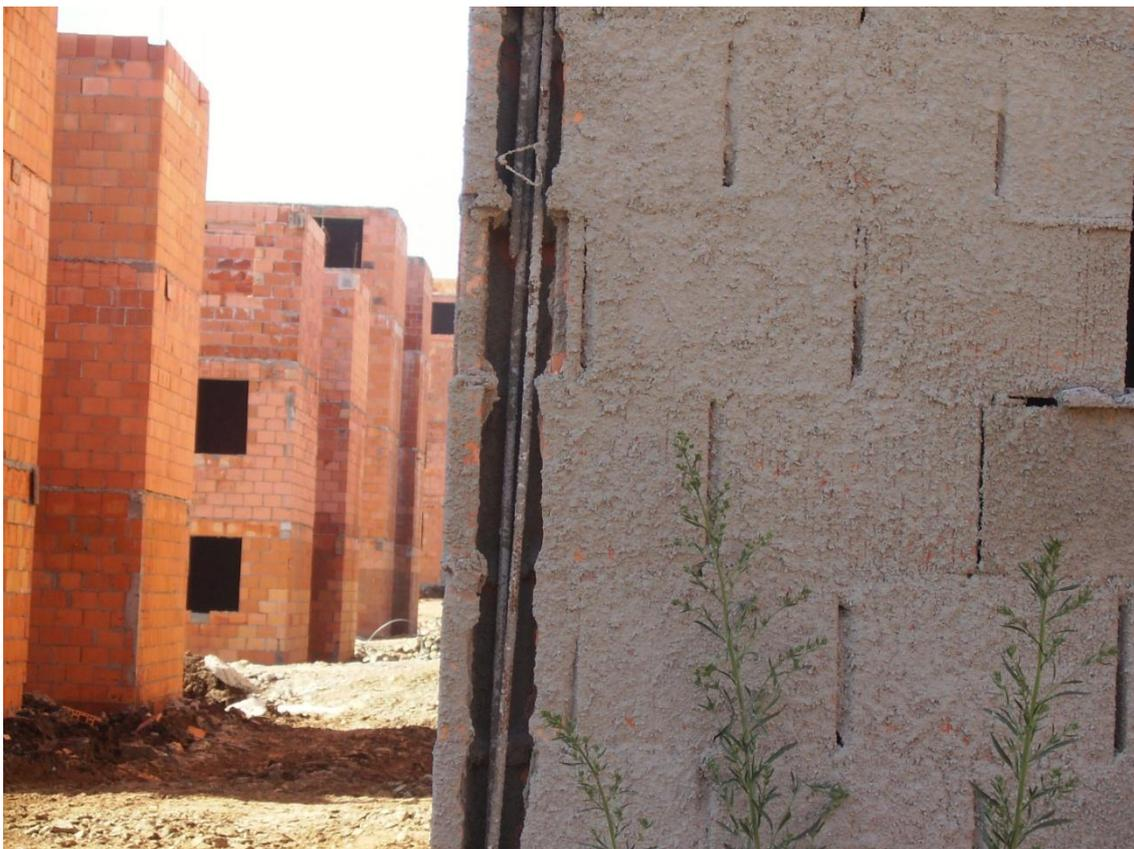
Figura 02- Graute executado, com bloqueio do vazio do bloco, por restos de blocos e argamassa.
