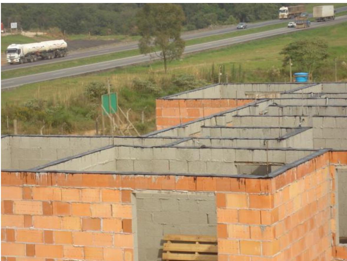
Figura 06- Junta de dilatação da laje de cobertura, com manta asfáltica. Fonte (canteiro de obra).
