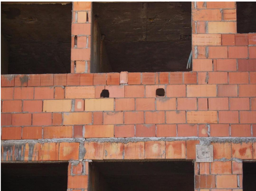
Figura 12 – Quebra dos blocos cerâmicos. Fonte (canteiro de obras).
