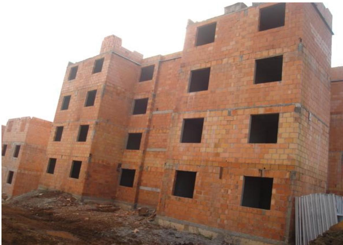
Figura 01-Alvenaria estrutural executada em blocos cerâmicos. Fonte (canteiro de obra).
