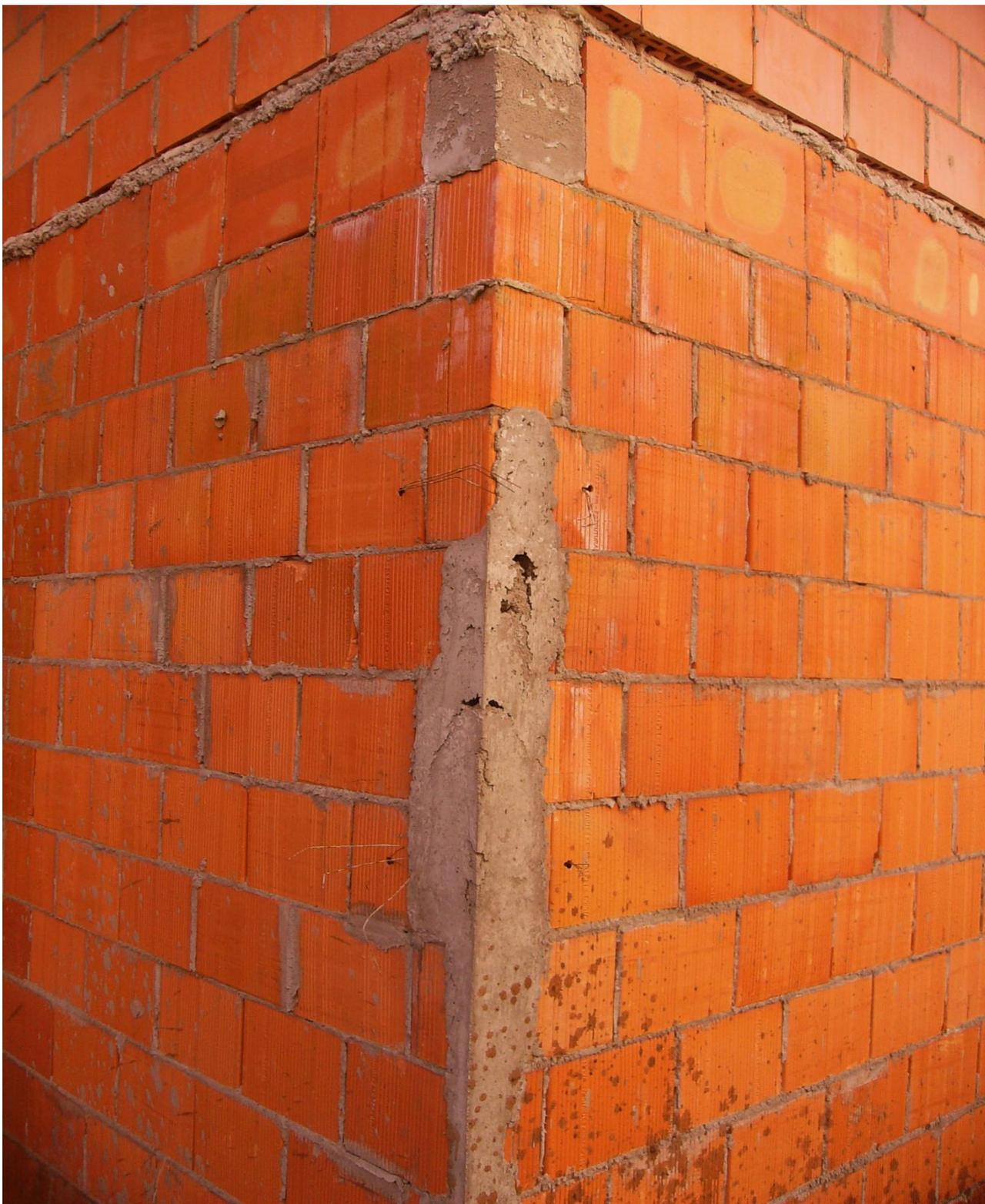
Figura 14 - Encontro da laje do 1º pavimento com a primeira fiada do 2º pavimento, desalinhada. Fonte (canteiro de obras).
