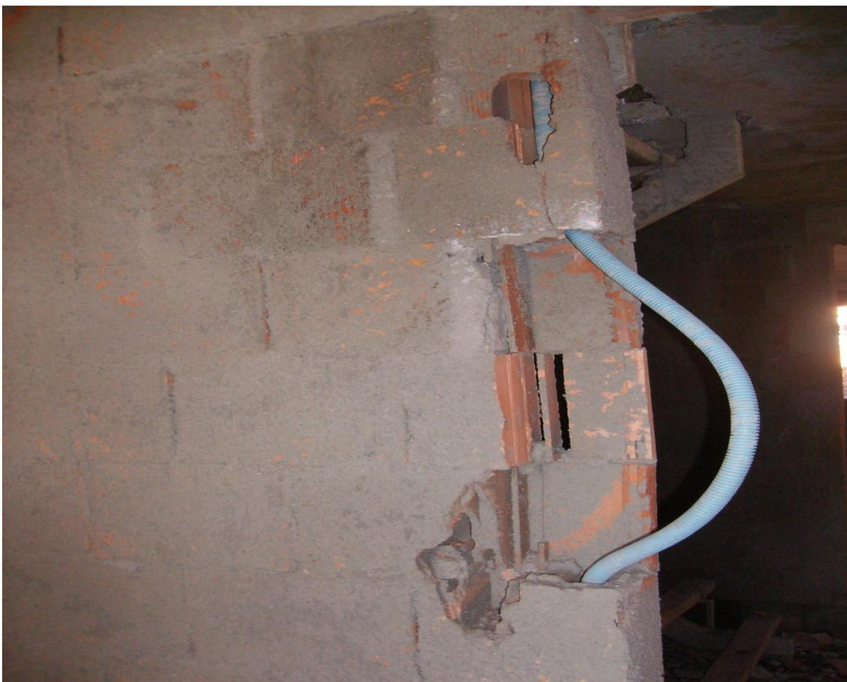
Figura 07: Embutimento de tubulações elétricas, elaborado de forma incorreta. Fonte (canteiro de obra).
