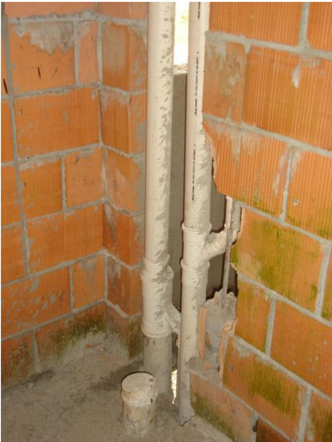
Figura 16 - Shafts de tubulações de esgoto elaborado de forma a quebrar o ponto de graute. Fonte (canteiro de obras).
