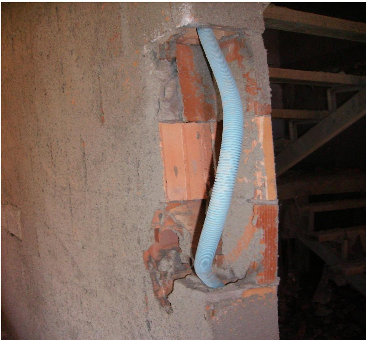
Figura 15- Quebra de alvenaria para passagem de tubulações. Fonte (canteiro de obra).
