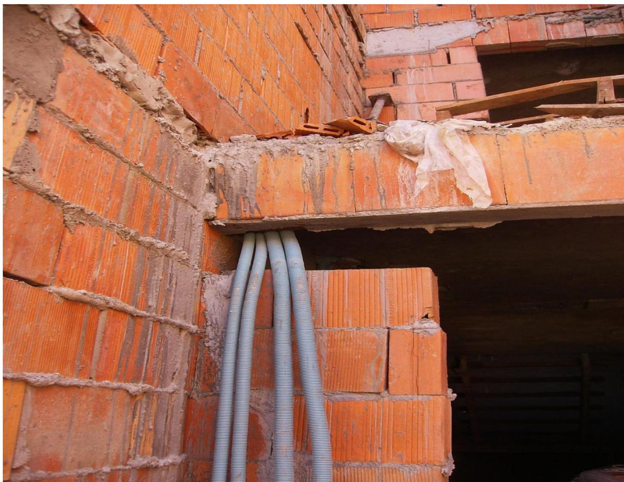
Figura 09- Exemplo de vergas e contra-vergas mal executadas. Fonte (canteiro de obras).
