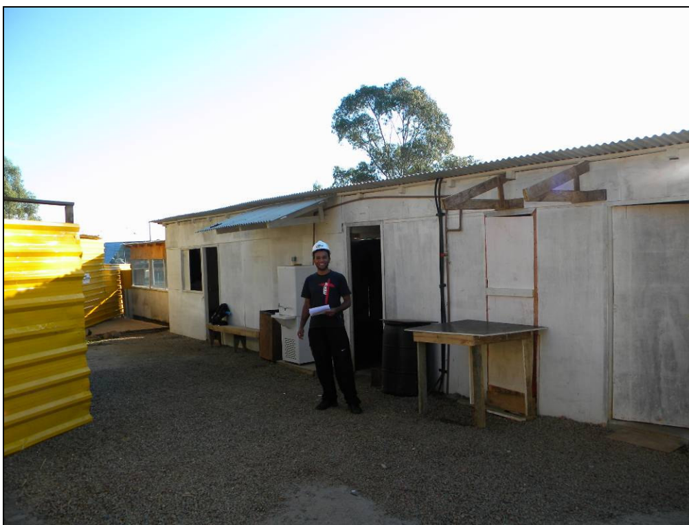
FOTO 19 – Área de vivência da obra G (Obra Grande porte)
