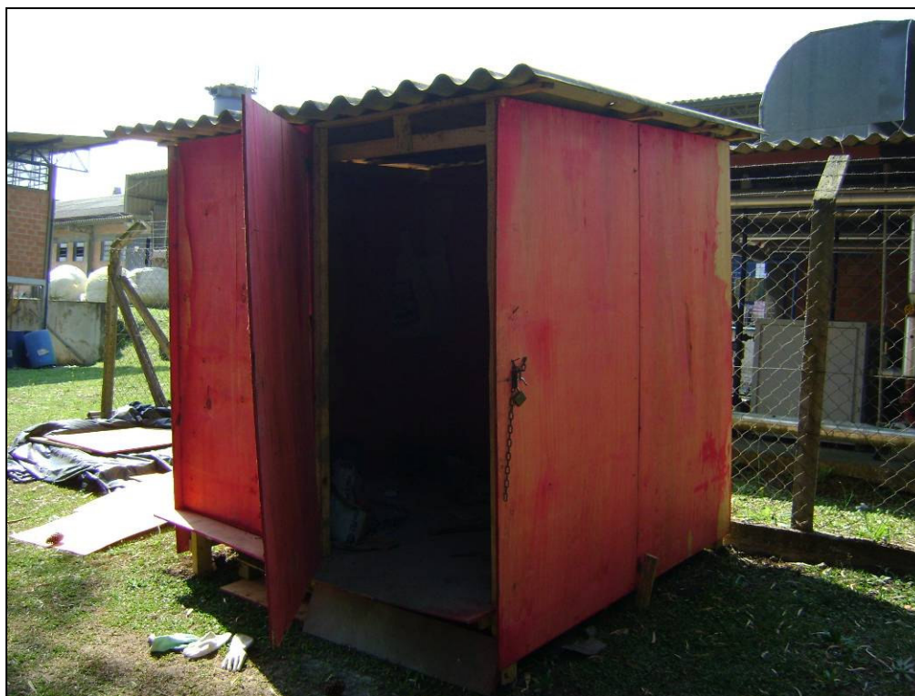
FOTO 02 – Vestiário da obra A (Obra pequeno porte)
