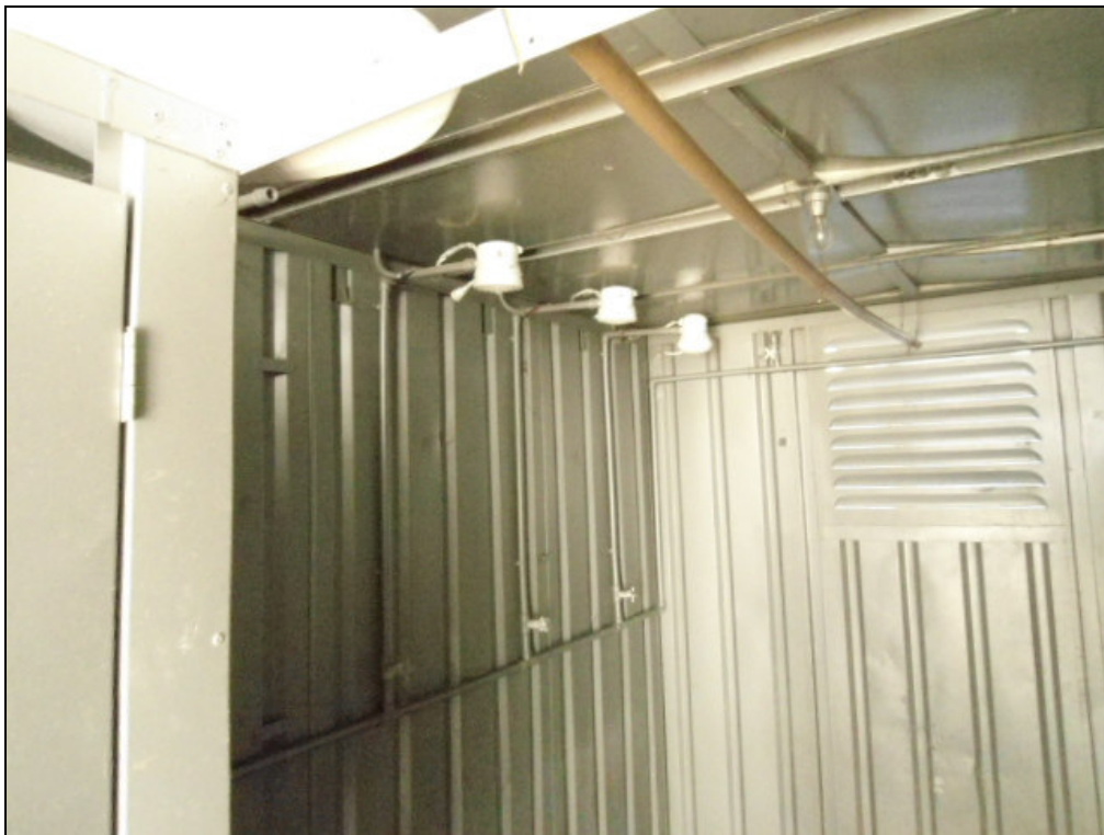
FOTO 06 – Chuveiro da obra B (Obra pequeno porte);
