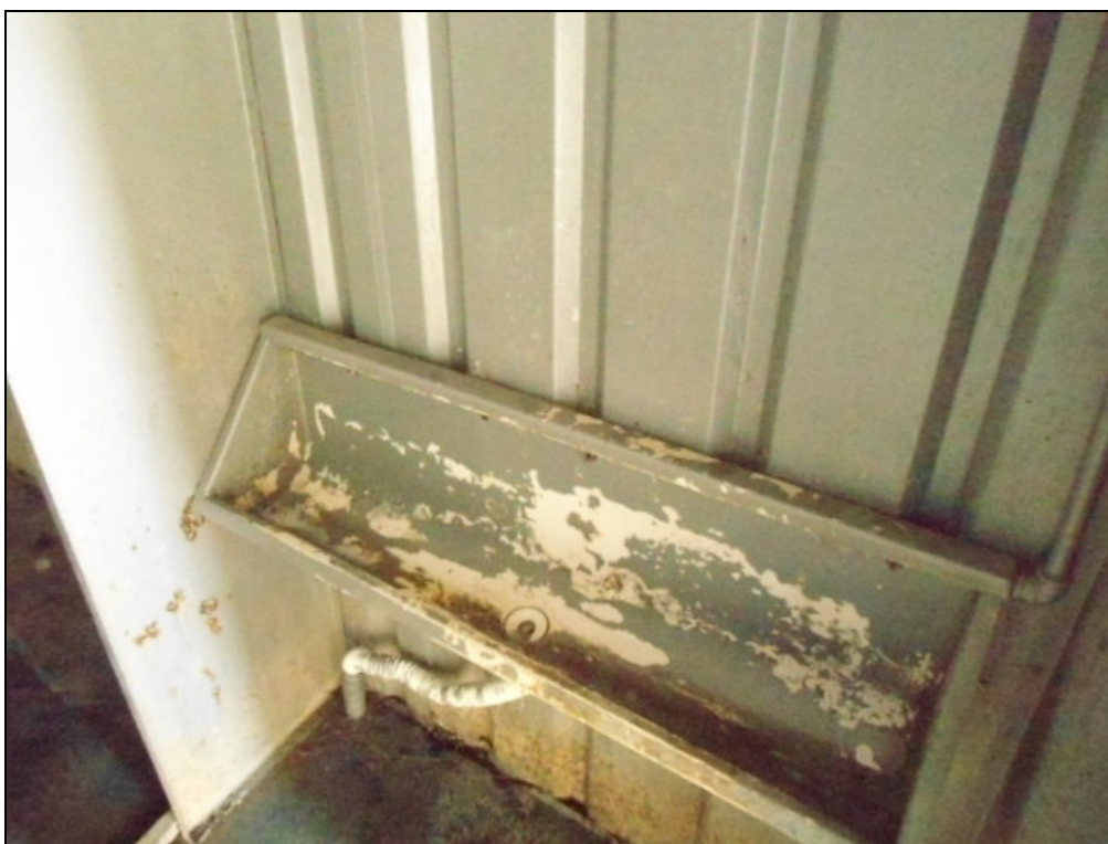
FOTO 07 – Mictório da obra B (Obra pequeno porte)
