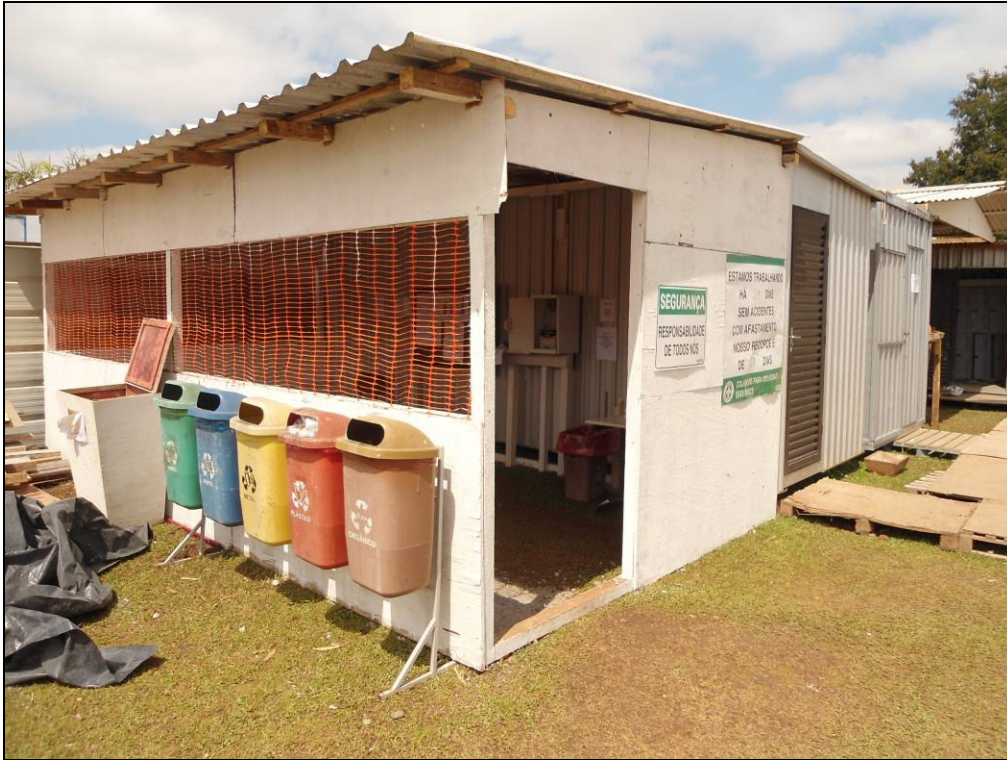
FOTO 05 – Refeitório da obra B (Obra pequeno porte)
