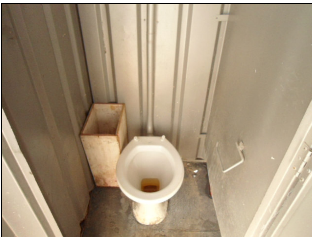
FOTO 08 – Banheiro da obra B (Obra pequeno porte)
