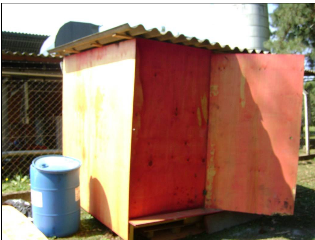
FOTO 01 – Vestiário da obra A (Obra pequeno porte)
