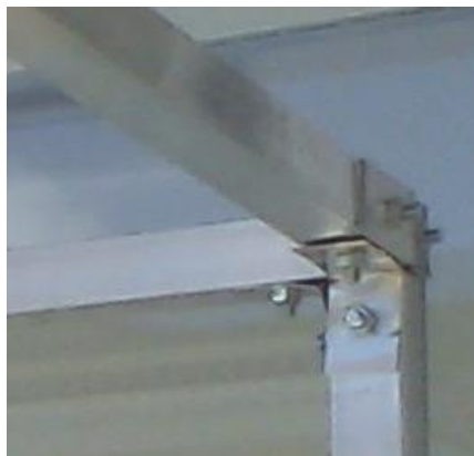
Figura 13: Ligação das barras de sustentação
