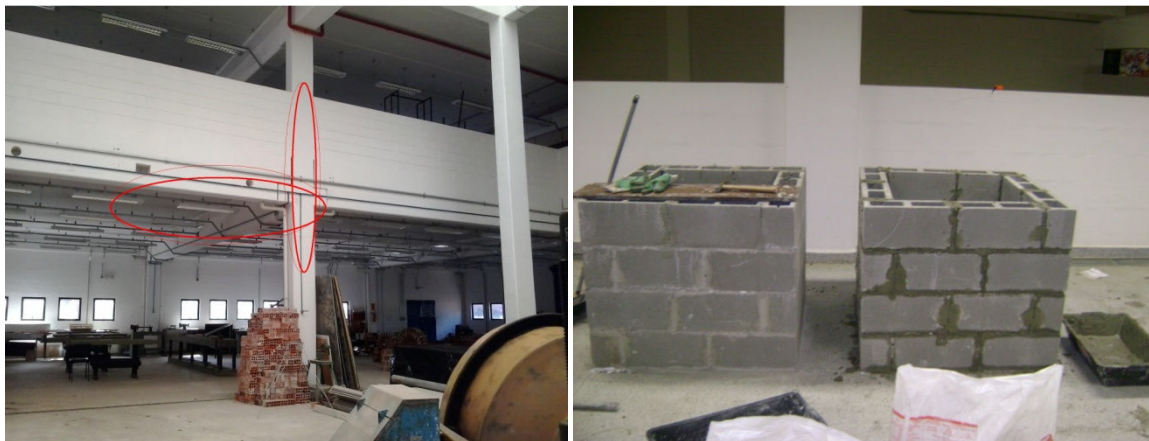
Figura 9 - Local de construção dos protótipos.
