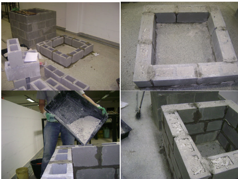
Figura 12 - Construção do protótipo contendo resíduo nos furos dos blocos.
