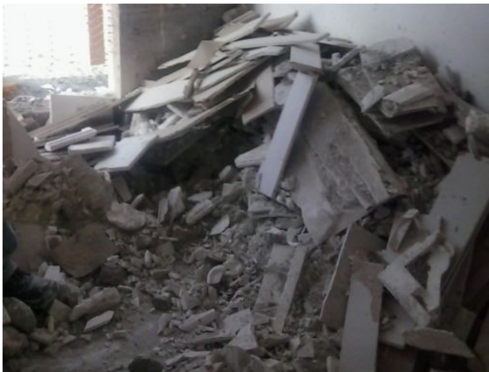
Figura 2 – Resíduos gerados durante a aplicação de gesso.
