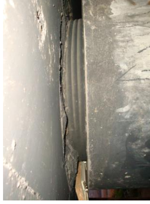
LATERAIS DO APARELHO DE APOIO ABAUÇADAS
