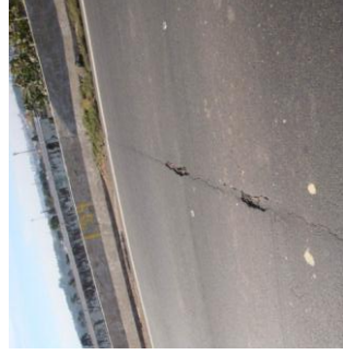
ASFALTO DETERIORADO
