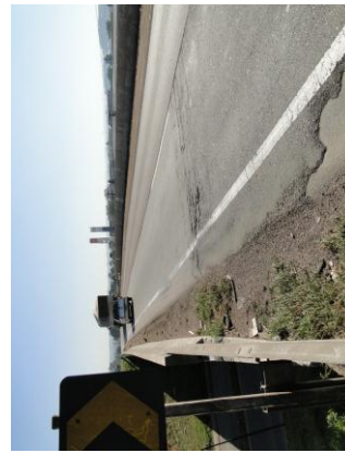
FISSURAS NA LAJE EM BALANÇO
