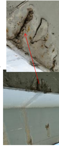
ARMADURA EXPOSTA NA LAJE EM BALANÇO
