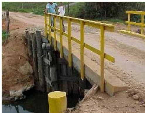
Figura 16 - Ponte com tabuleiro misto de madeira e concreto Fonte: Calil Junior (2006 p. A15).
