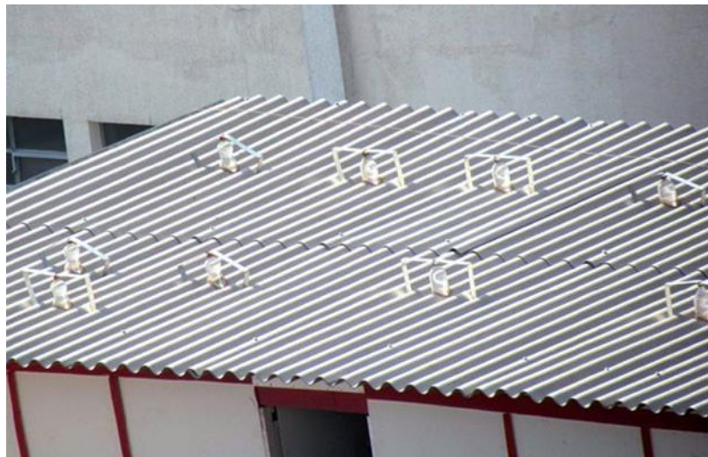
Figura 3 - Galpão de instalações provisórias de uma obra com a fixação de garrafas PET com hastes metálicas
