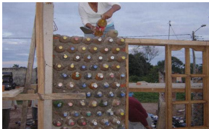
Figura 1 - Modelo de parede usando garrafas PET
