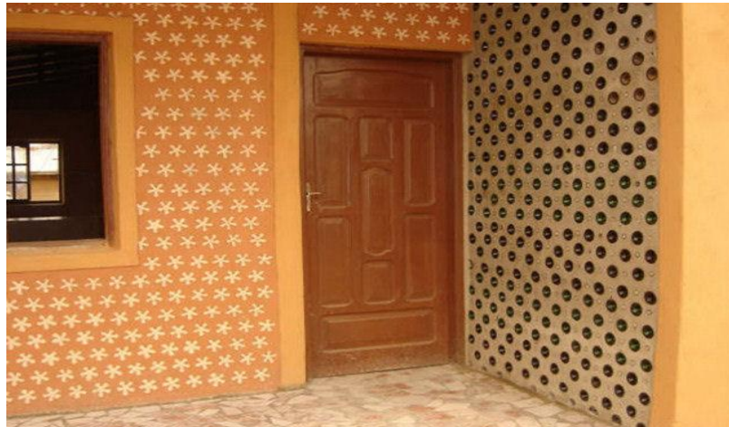
Figura 2 - Casa acabada com paredes de garrafas PET
