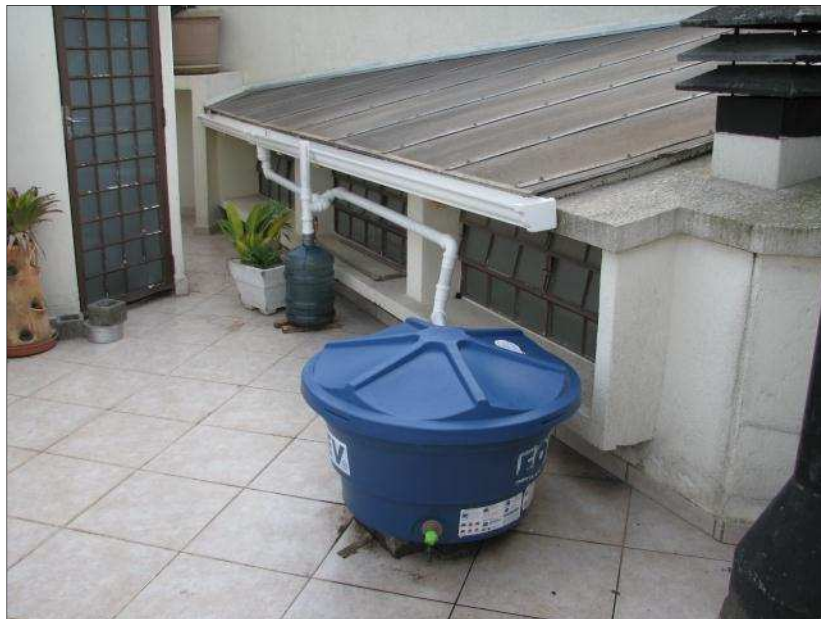
Figura 3 – Vista do sistema de captação da água de chuva a partir do lado direito Fonte: Hirt e Santos (2011).
