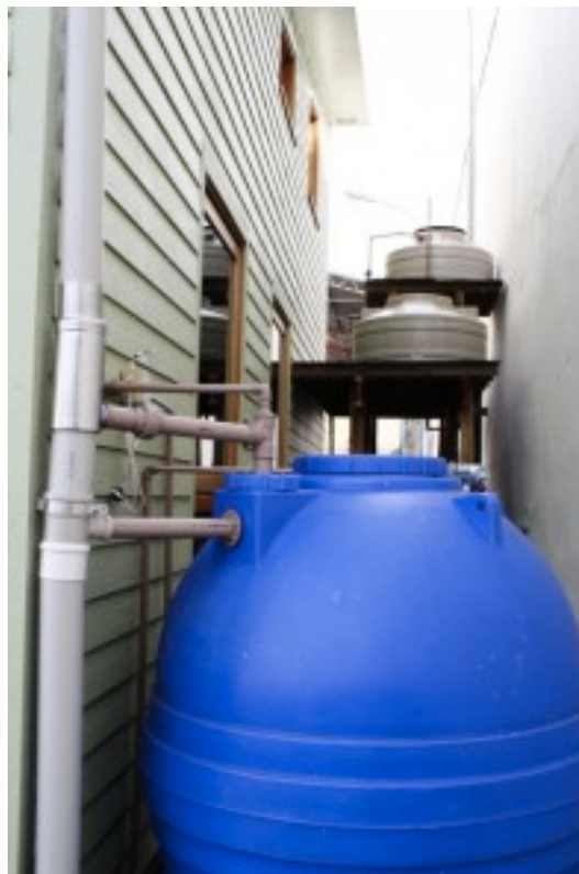
Figura 9 - Detalhe do sistema de aproveitamento de água de chuva FONTE: (ESCRITÓRIO VERDE ONLINE, 2012)
