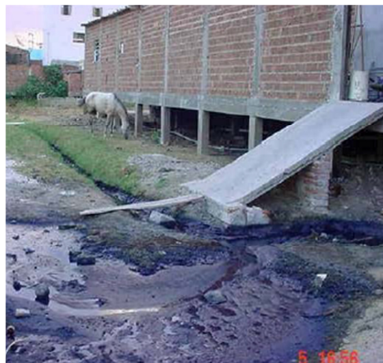
Figura 3 - Detalhe do lançamento de efluentes.
