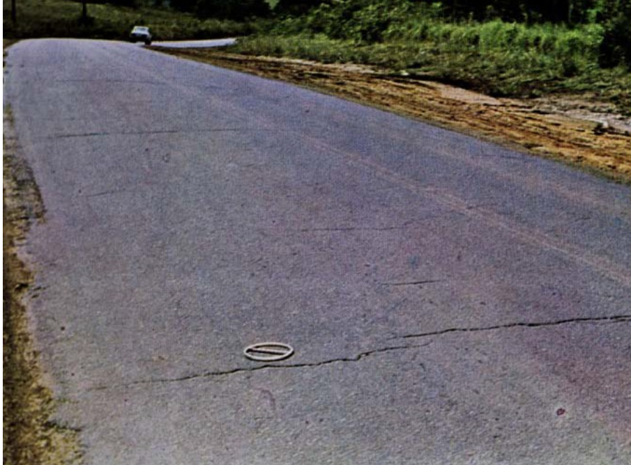
FIGURA 2 – TRINCA TRANSVERSAL
