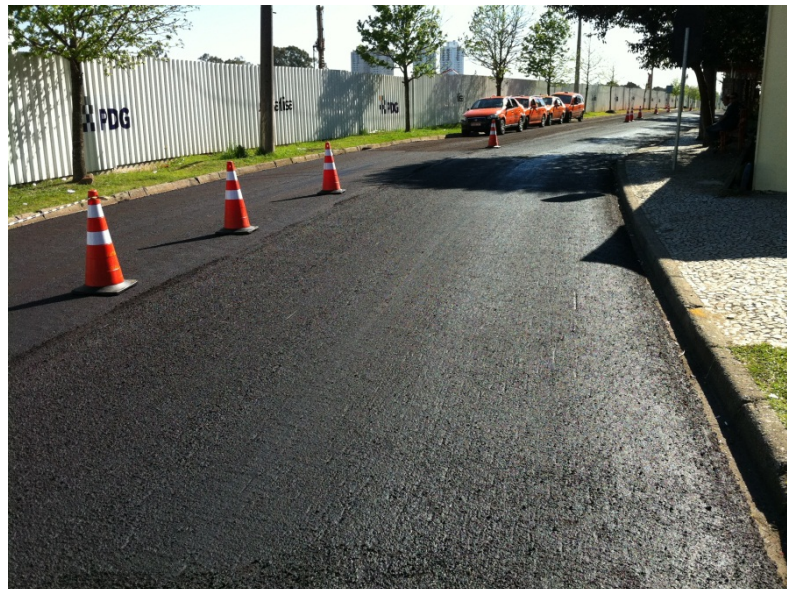
FIGURA 12- PAVIMENTAÇÃO COM RECAPEAMENTO EM CONCRETO ASFÁLTICO COM LIGANTE DE BORRACHA EM CURITIBA
