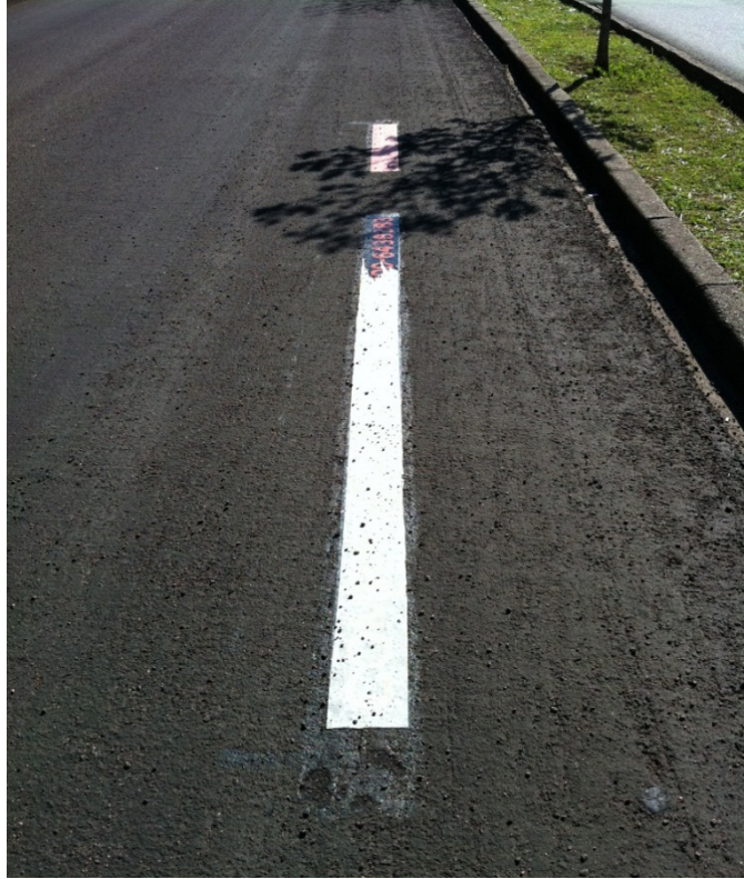
FIGURA 15 - RECAPEAMENTO APÓS PASSAGEM DE DUTOS DE GÁS EM RUA DE CURITIBA FONTE: AUTOR (2011)
