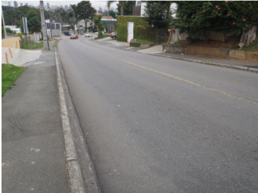
FIGURA 33 - TRECHO AB8: VISÃO GERAL
