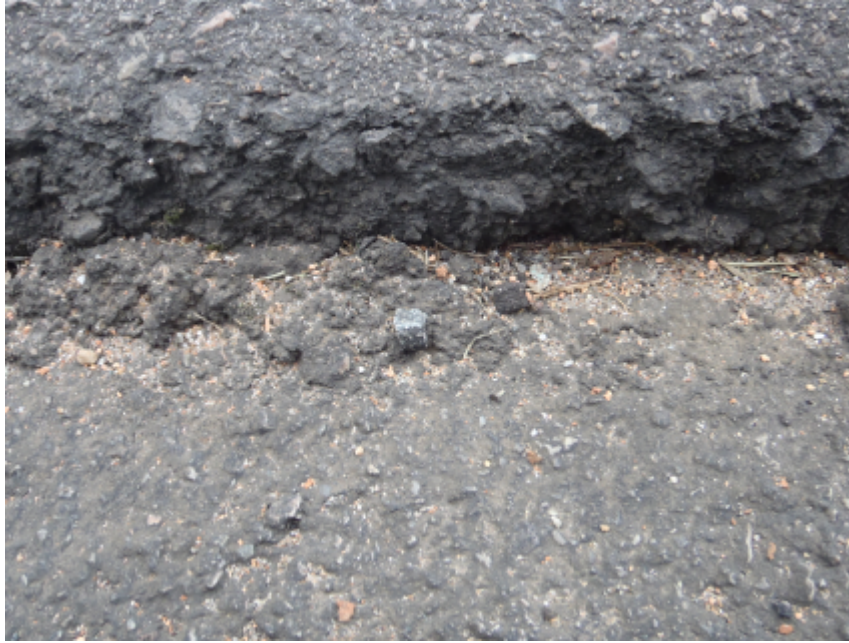
FIGURA 32 - TRECHO 2 AB8: PERFIL DO ASFALTO BORRACHA
