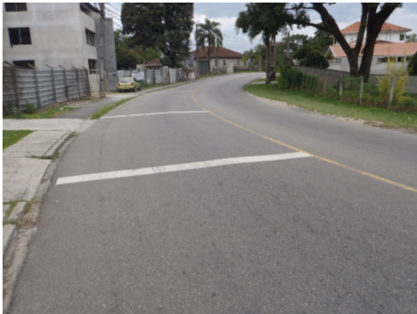
FIGURA 21 - TRECHO 1 AB8: TRECHO SEM DEFEITOS FONTE: AUTOR (2012)
