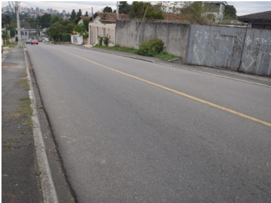
FIGURA 31 - TRECHO 2 AB8: VISÃO GERAL
