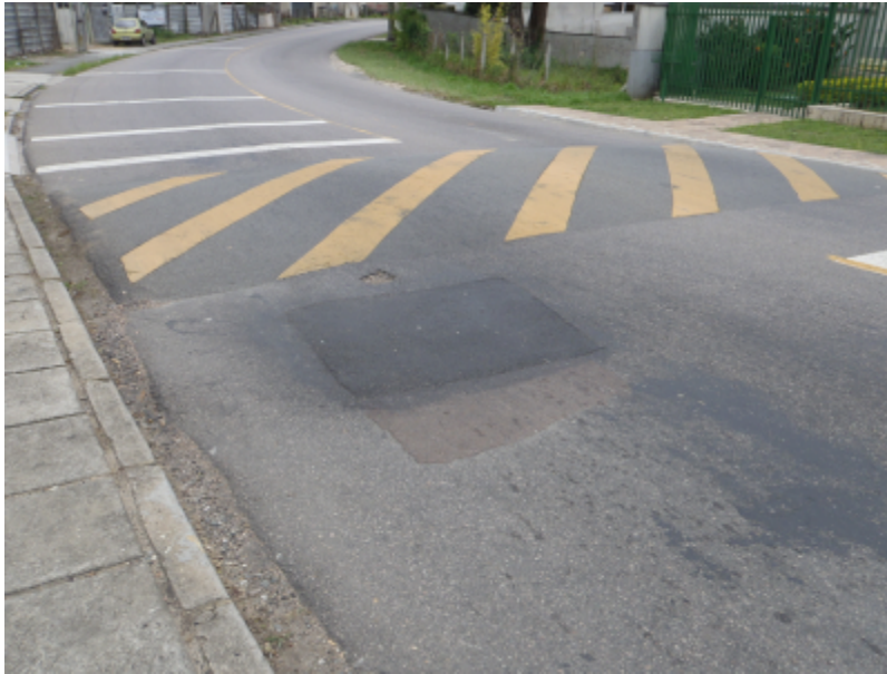
FIGURA 20 - TRECHO 1 AB8: REMENDO DE PANELAS E/OU BURACOS FONTE: AUTOR (2012)
