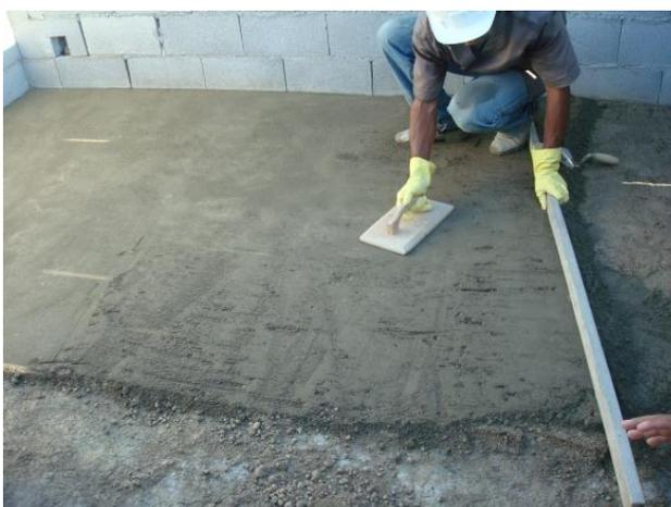
Figura 2.9 - Regularização de laje com uso da vermiculita
