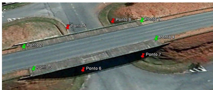
Figura 80 - Sequência de inspeção viaduto Padre Paulo Warkocz
