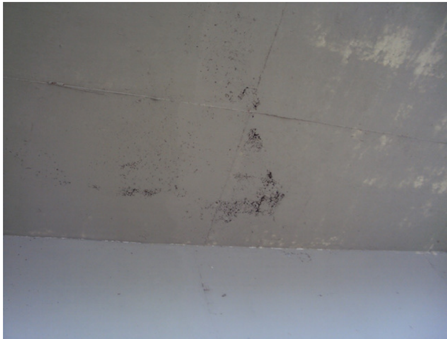
Figura 61 – Ninhos de concretagem no fundo de laje da viga caixão (ponto 8)
