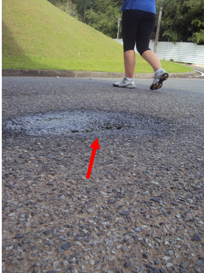
Figura 63 – Sinais de lixiviação na pista sob o viaduto
