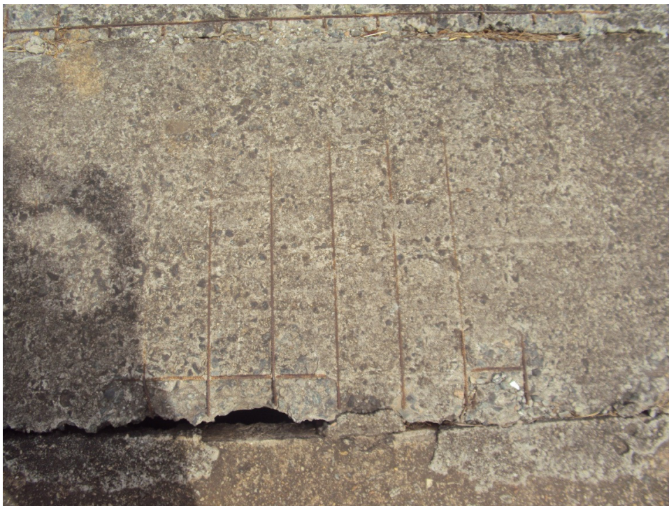
Figura 14 – Lixiviação nas placas do passeio (todo)
