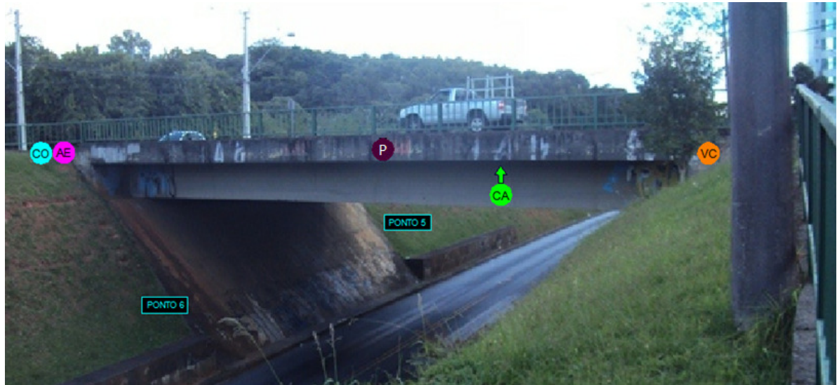
Figura 43 – Mapeamento Rua Dr. Basílio Vicente de Castro – Sentido Ecoville
