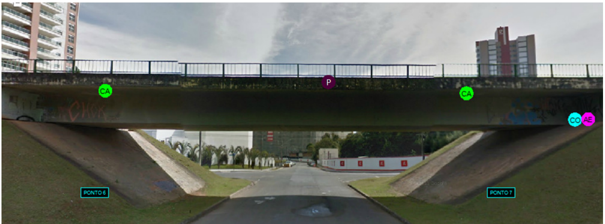
Figura 57 - Mapeamento Rua Oscar Borges de Macedo Ribas – Sentido Centro face sul
