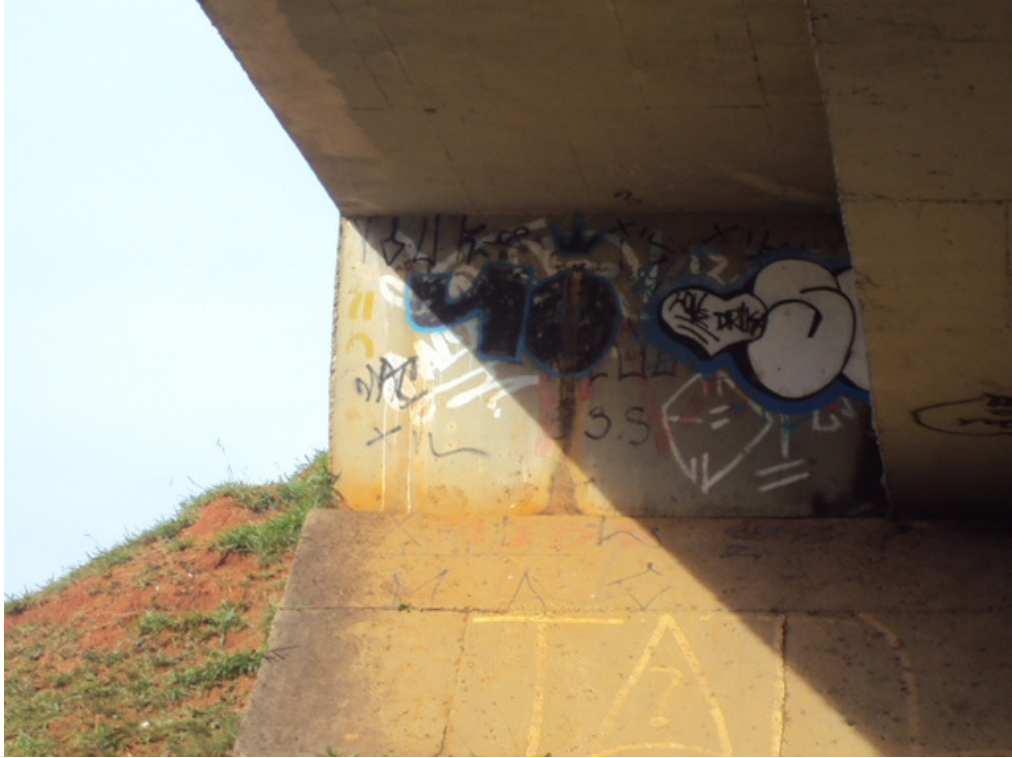
Figura 88 - Lixiviação na cortina (ponto 8)
