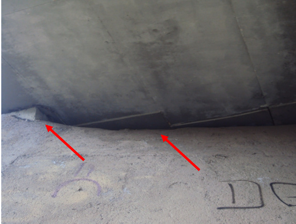
Figura 53 – Presença de formas no fundo da viga e servindo como aparelho de apoio
