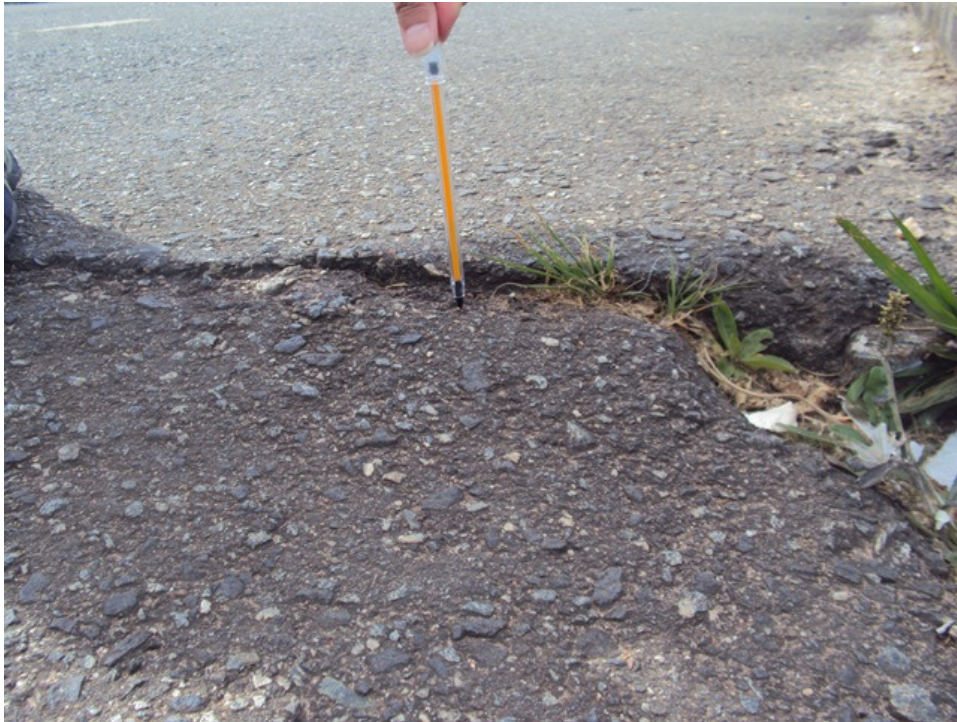
Figura 49 – Recalque na cabeceira da pista (ponto 1-4)
