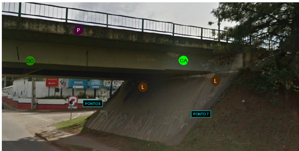
Figura 67 – Mapeamento Rua João Falarz – Sentido Ecoville face leste
