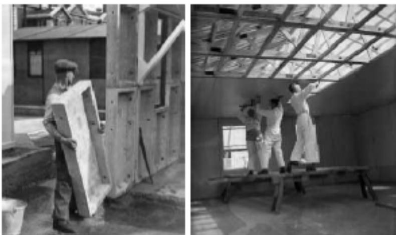
Figura 1. Exemplo da montagem de uma habitação pré-fabricada, Fonte: GAFFEY, et al.(2006)
