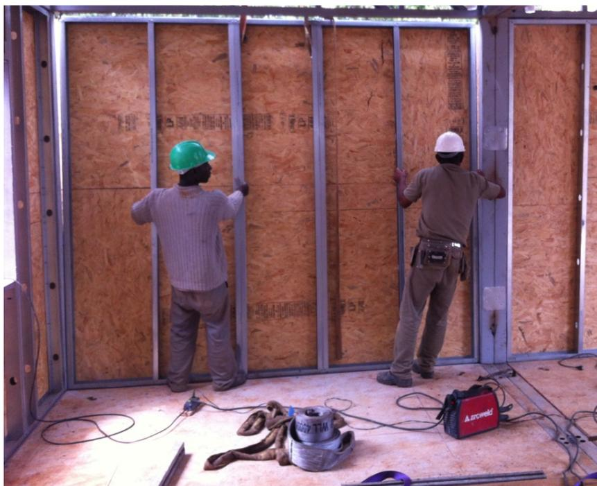
Figura 30: Fixação da Parede na Estrutura do Módulo
