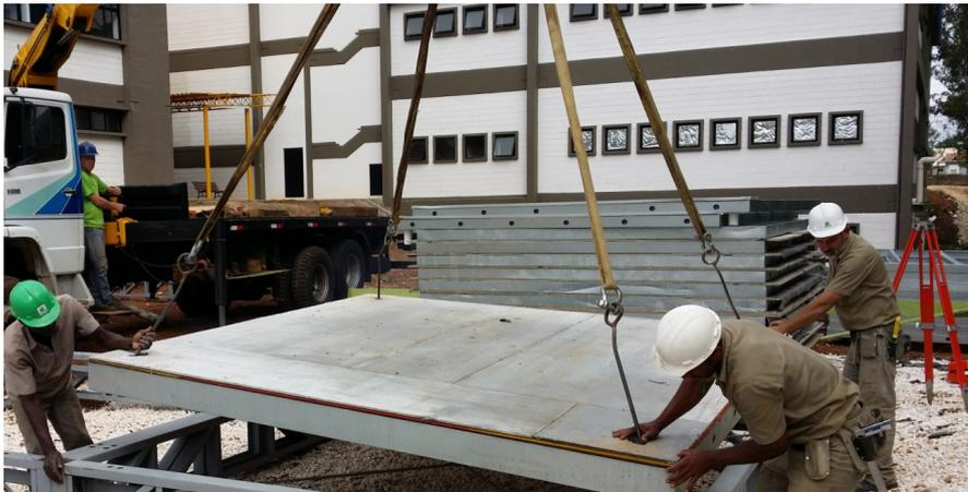
Figura 32: Apoio do Piso no Quadro Estrutural
