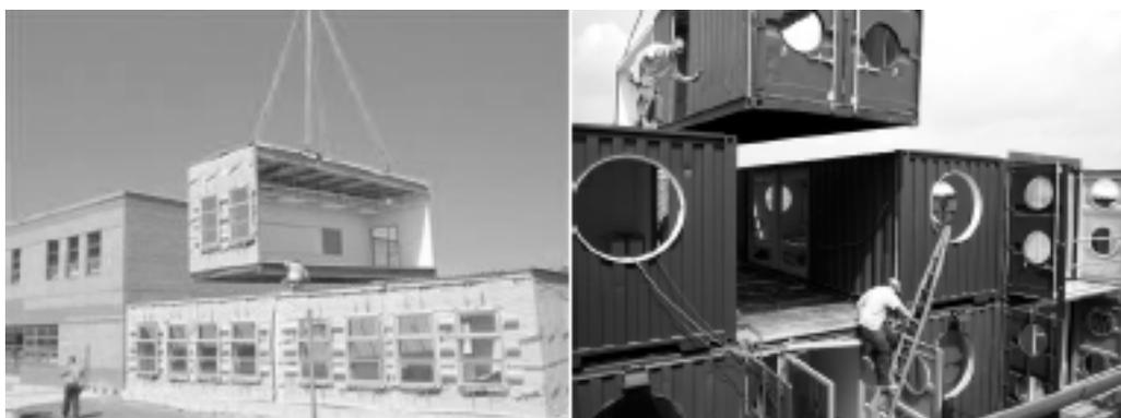
Figura 4. Exemplo de sistemas modulares parcialmente abertos.
