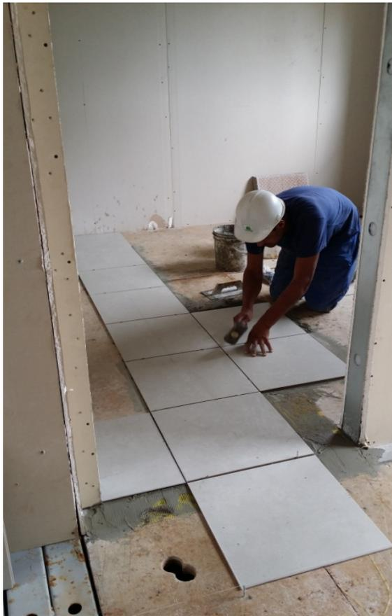
Figura 33: Colocação do Piso Cerâmico
