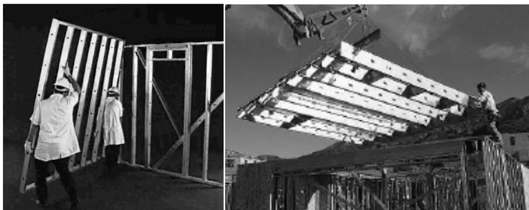
Figura 6. Exemplo de sistemas construtivos de elementos modulares.
