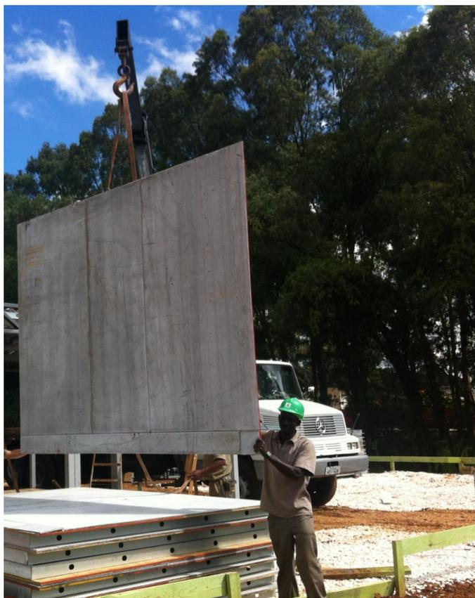
Figura 29: Içamento das Paredes externas
