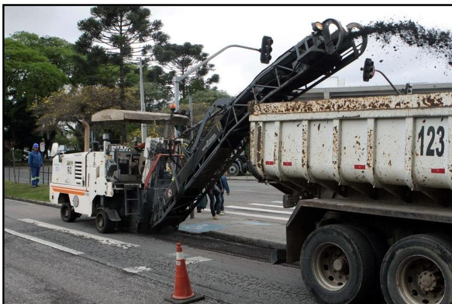
**Figura 2 - Obra para recuperação de pavimentação em Curitiba.
