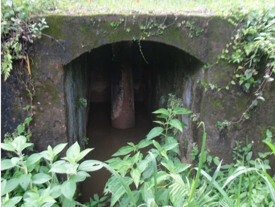
Figura 10 – Antigo canal de fuga da MCH de Rio Branco do Sul/PR Fonte: Autoria própria (2014)
