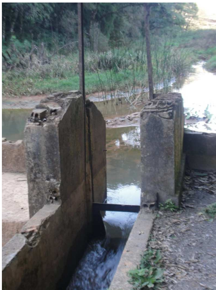
Figura 22 – Tomada d'água da MCH de Rio Branco do Sul/PR Fonte: Aatoria própria (2014)
