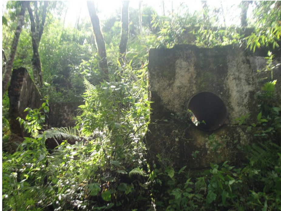
Figura 8 – Câmara de carga da MCH de Rio Branco do Sul/PR
