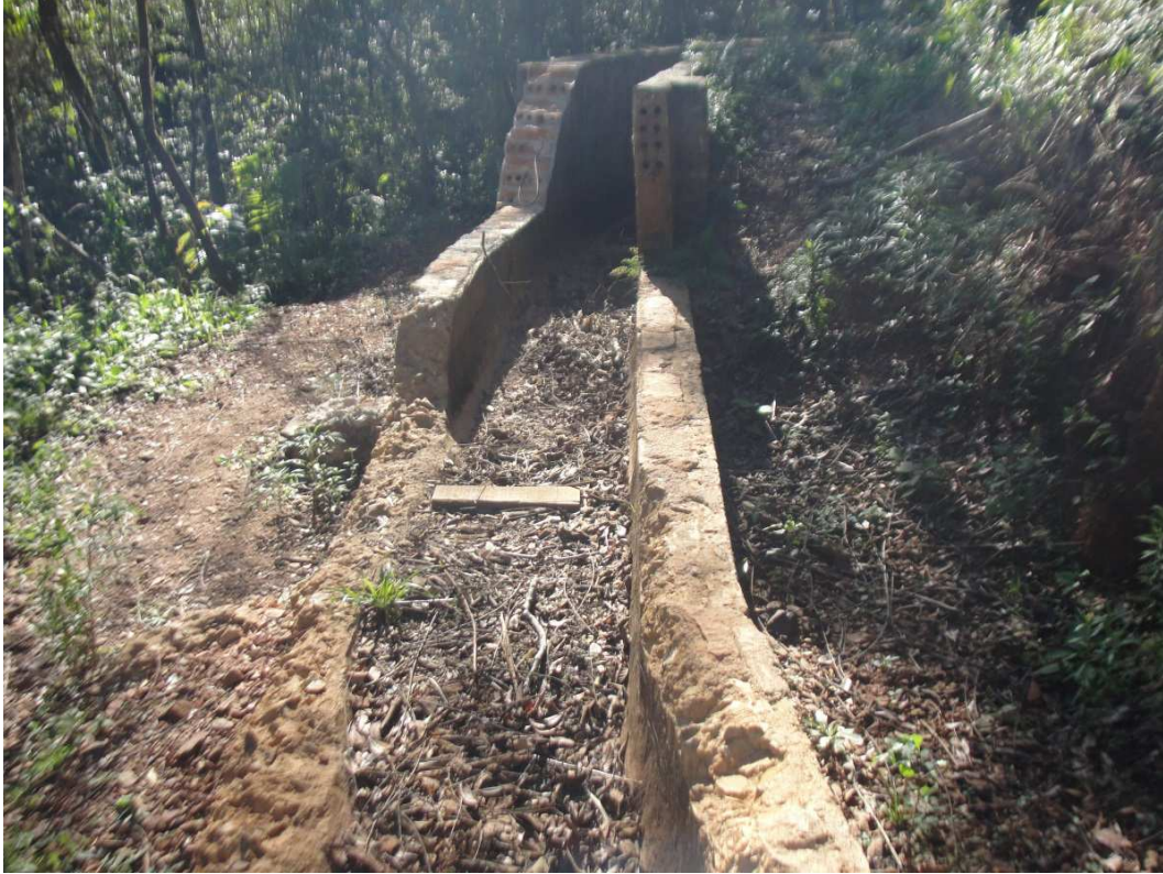
Figura 20 – Local da câmara de carga da opção 2 da MCH de Rio Branco do Sul/PR Fonte: Autoria própria (2014)
