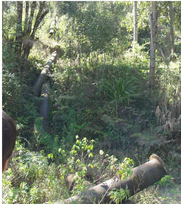
Figura 11 – Antigo conduto forçado da MCH de Rio Branco do Sul/PR Fonte: Autoria própria (2014)
