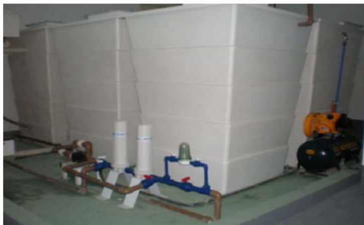
Figura 9 – Edifício Royal Blue – ETAC. Fonte: Santos, 2008.
