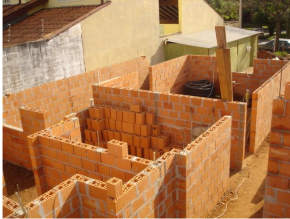
Figura 1 - Alvenaria de blocos vazados. Fonte: D2RENGENHARIA, 2014
