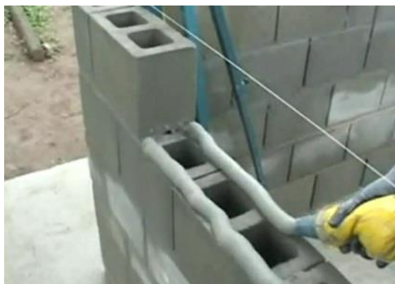
Figura 2 - Alvenaria de blocos de concreto. Fonte: ARQUITECASA, 2014
