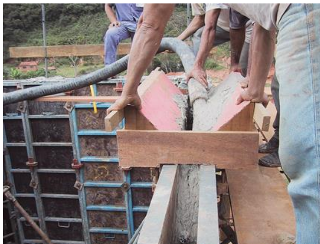
Figura 4 - Fôrma sendo preenchida por concreto. Fonte: Composte, 2014.
