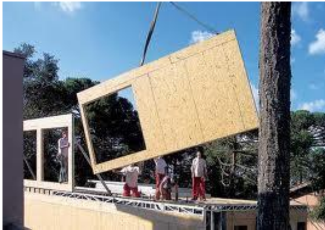
Figura 5 - Painel pré-moldado sendo transportado por grua. Fonte: Composte, 2014.
