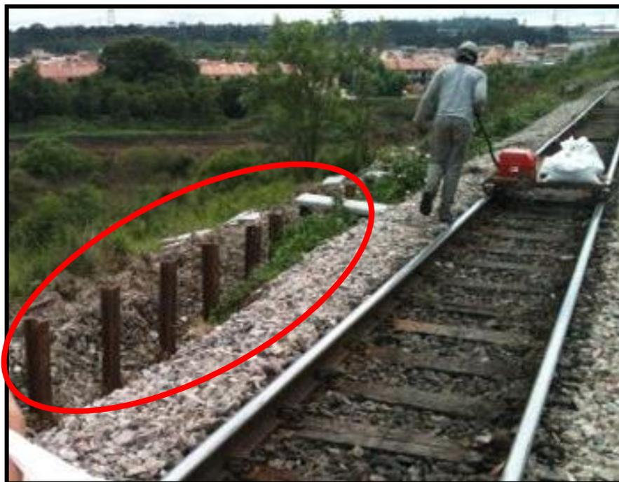
Figura 28 - Exemplo de reforço de solo com estaca de trilho.
