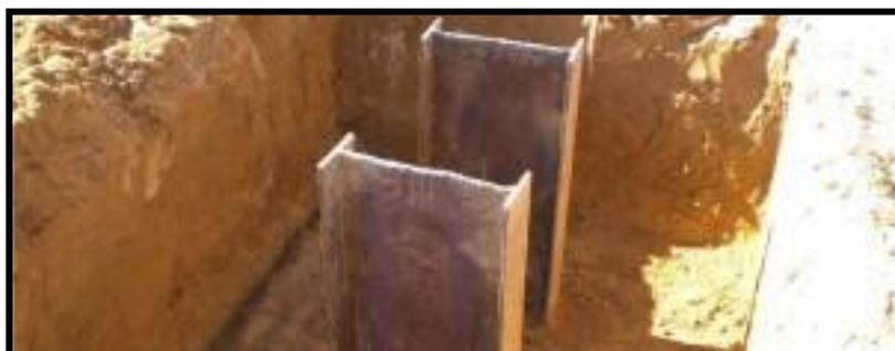
Figura 21 - Exemplo de reforço com estacas de perfil de aço.
