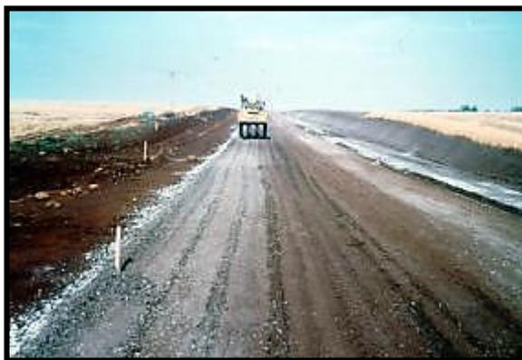
Figura 19 - Preparação de um trecho em solo-cimento.
