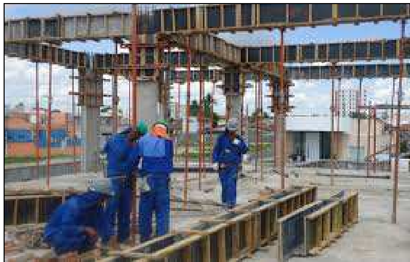
Figura 24 – Montador de Escoras Metálicas.
