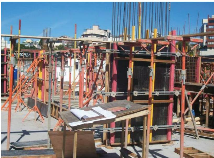
Figura 17 – Fundos de vigas fixados nos pilares
