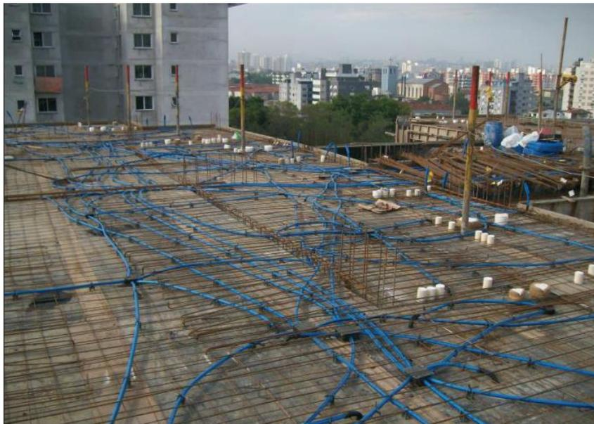
Figura 20 – Laje pronta para concretagem
