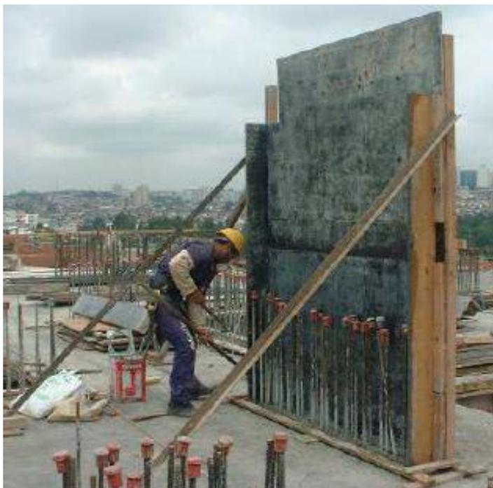
Figura 15 – Fechamento dos painéis do pilar
