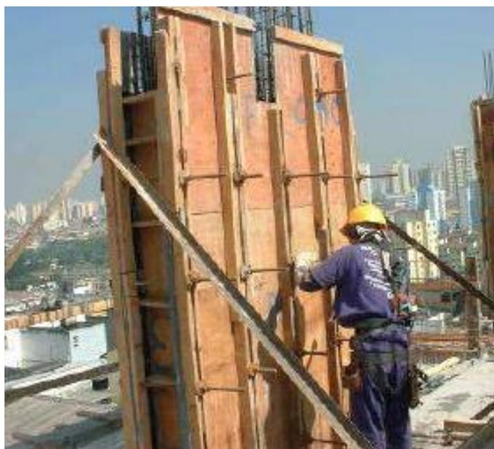
Figura 16 – Fixação das formas do pilar
