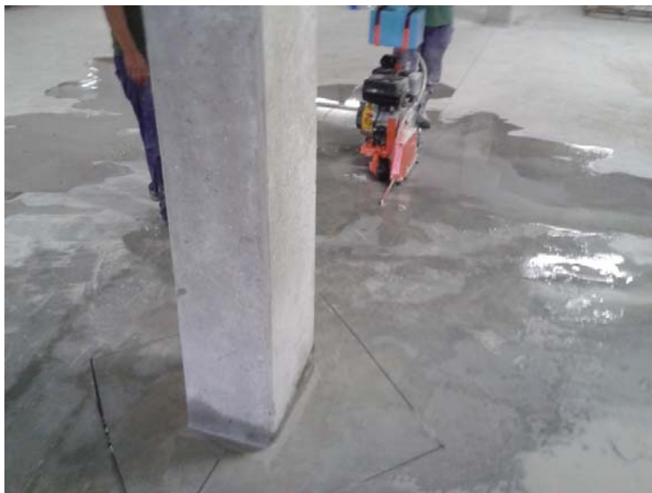
Figura 43: Execução do corte.
