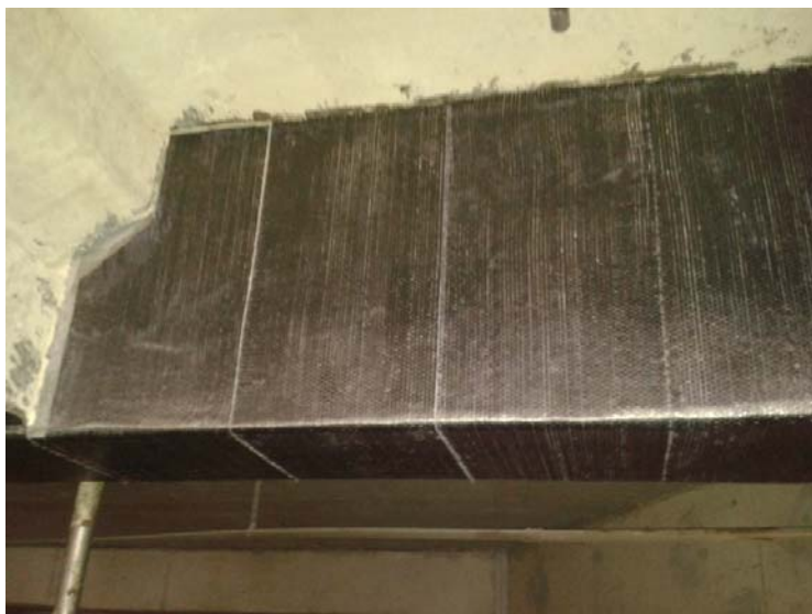
Figura 36: Reforço estrutural com fibra de carbono.
