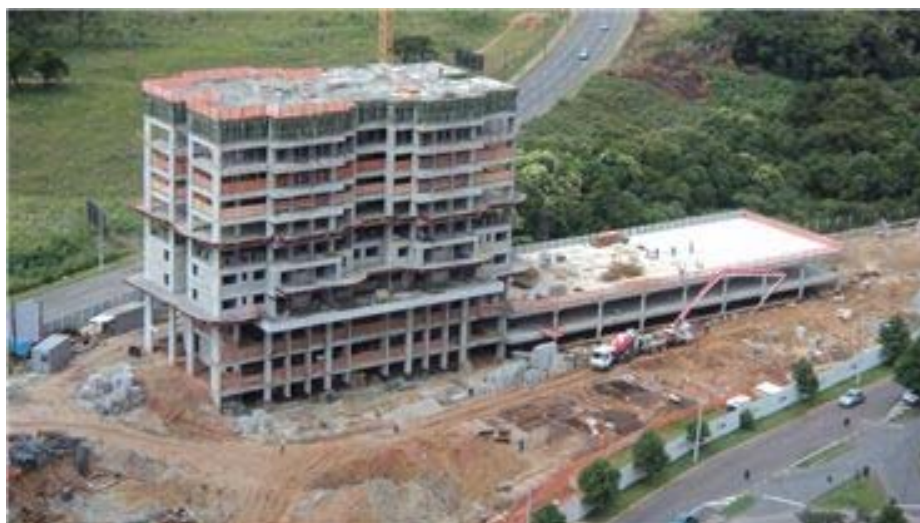
Figura 24: Estrutura convencional e pré-moldado
