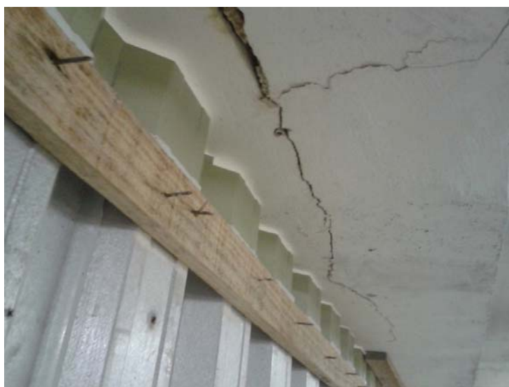
Figura 46: Vigas V153 e V152 – situação executada
