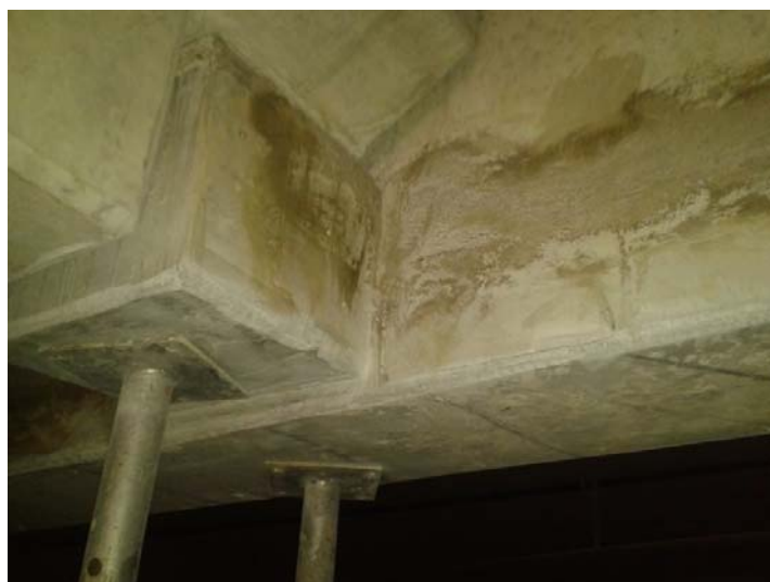
Figura 34: Preenchimento da rachadura da viga (acabamento).
