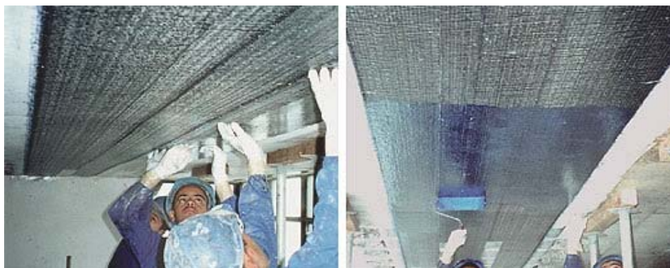
Figura 21: Aplicação da fibra e segunda camada de saturação.
