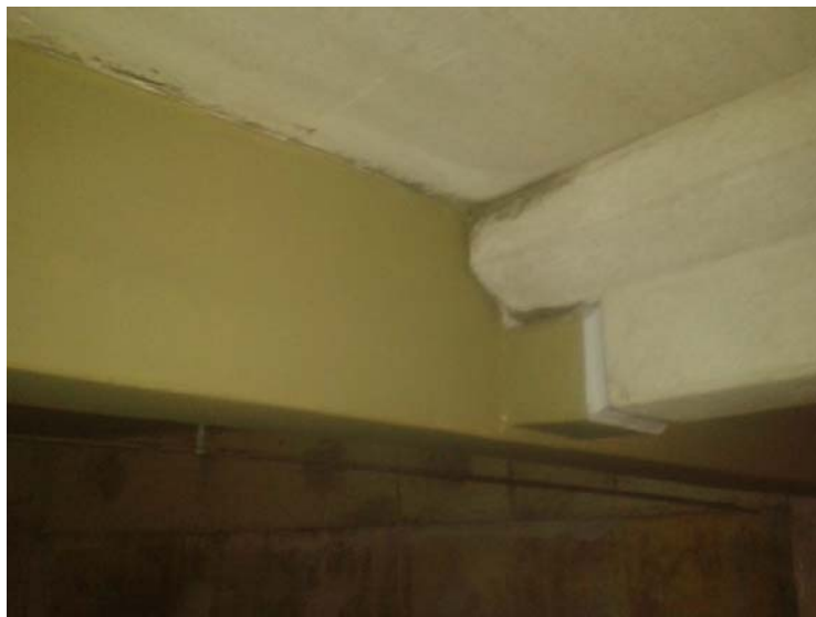
Figura 37: Acabamento final do sistema de fibra de carbono.
