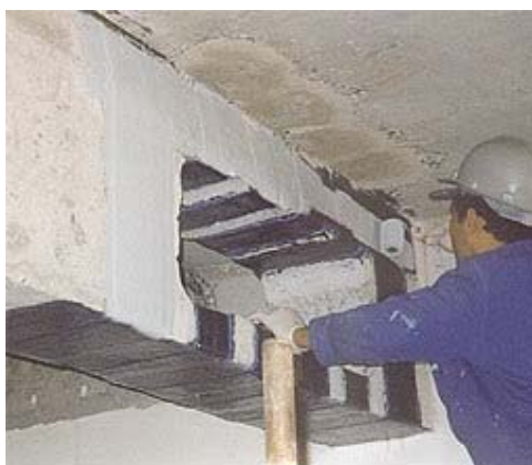
Figura 22: Aplicação da camada de proteção e/ou estética.
