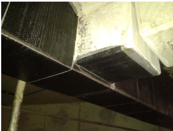
Figura 35: Reforço estrutural com fibra de carbono.
