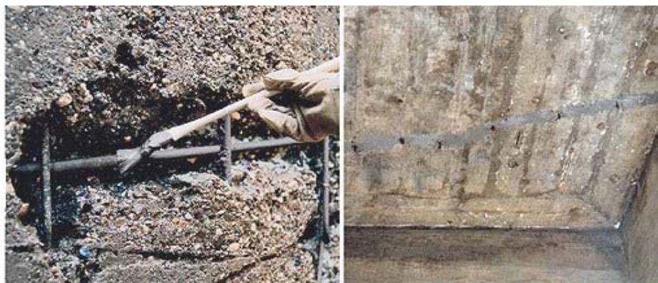
Figura 18: Passivação de armaduras e injeção de fissuras por epóxicos.
