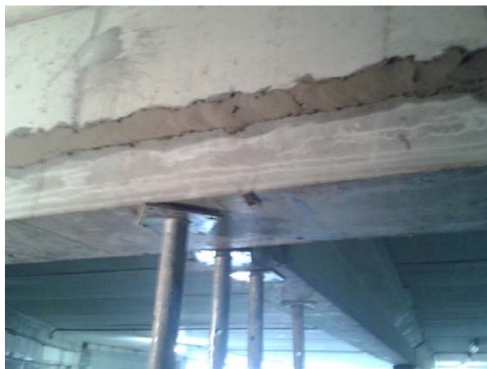
Figura 33: Preenchimento da rachadura da viga (2ª camada).
