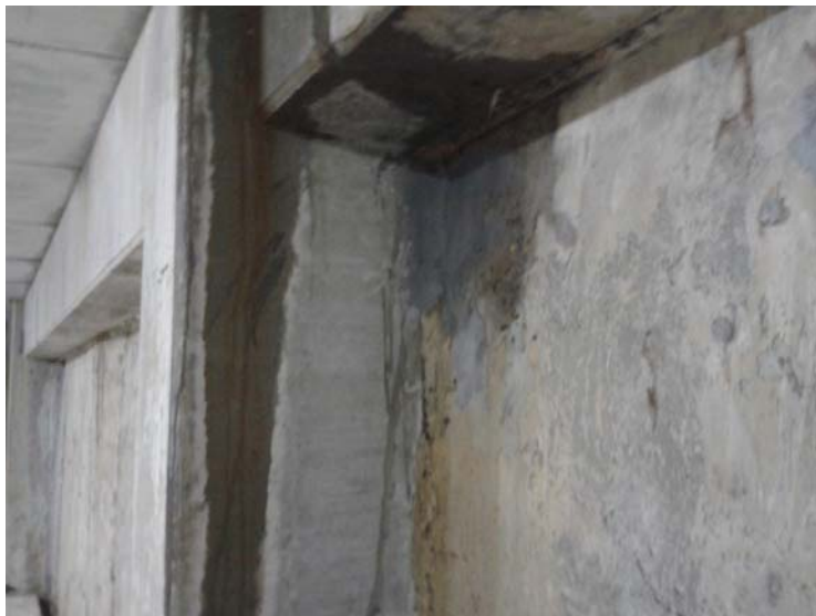
Figura 54: Cortina de concreto armado e estrutura pré-moldada – Amostra 42
