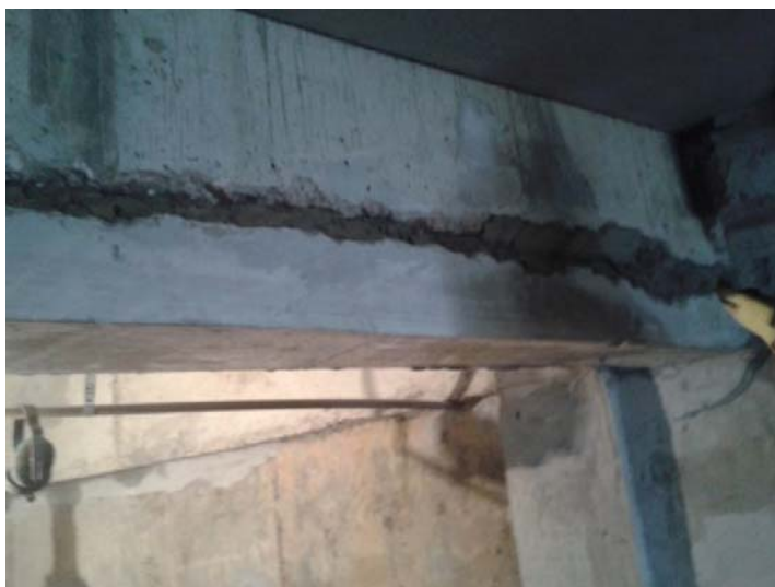
Figura 32: Preenchimento da rachadura da viga (1ª camada).
