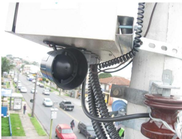
**Figura 57 – Sirene fixada em um Ponto de Videomonitoramento**
