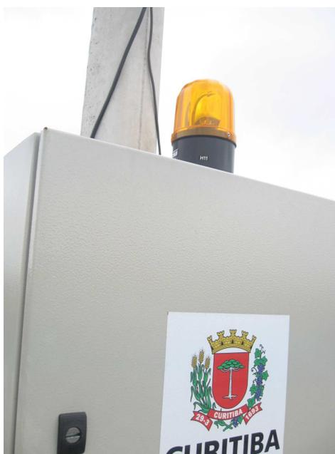
**Figura 58 – Sinalização rotativa instalada em um Ponto de Videomonitoramento**
