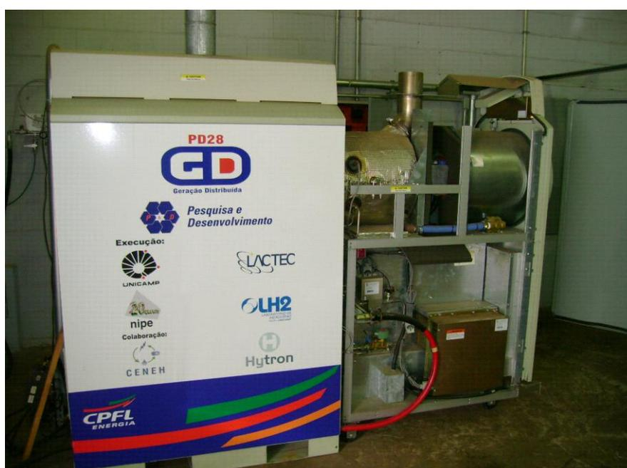
Figura 1 - Microturbina Capstone 30 kW instalada na planta piloto
