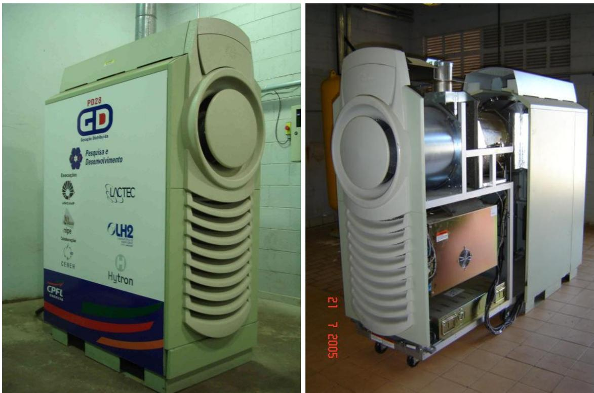
**Figura 12 - Microturbina Capstone C30 instalada no *site* de estudos de GD**
