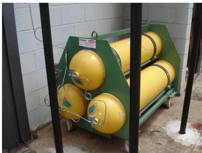
**Figura 13 - Cilindros para armazenamento de gás natural para a MT**
