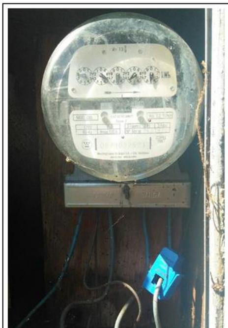
Figura 25 – Detalhe da montagem do sensor de corrente não invasivo
