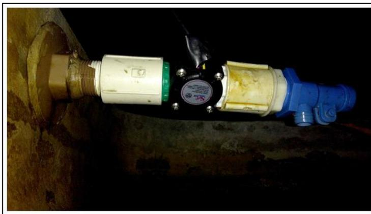
Figura 27 –Montagem do módulo de medição do consumo de água
