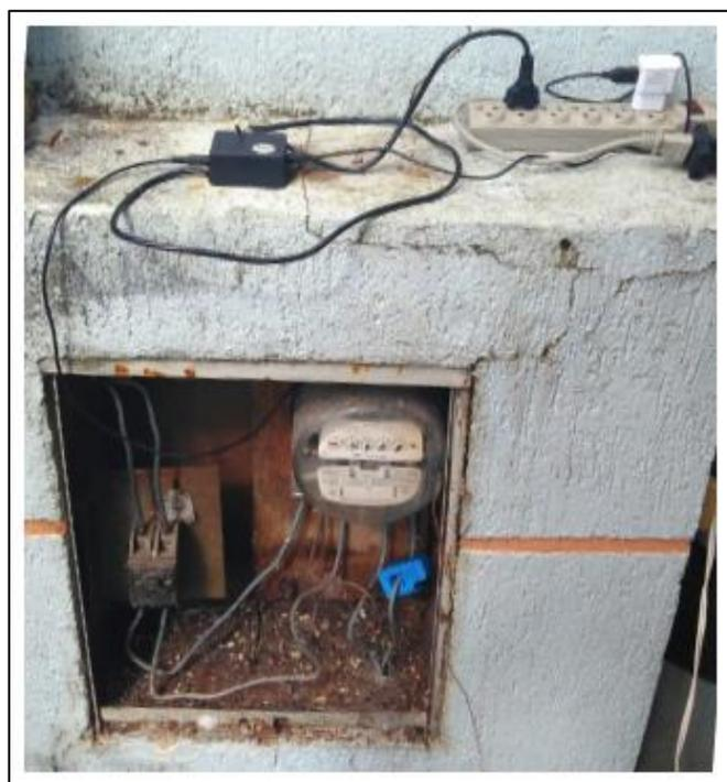
Figura 26 – Montagem do módulo de medição de corrente e tensão elétrica.
