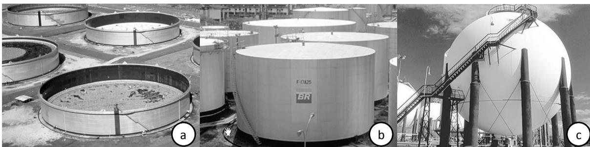
**Figura 5 – Tipos de Tanques. a) Tanque Cilíndrico com Teto Flutuante, b) Tanque Cilíndrico com Teto Fixo e c) Tanque Esférico com Teto Fixo.**
