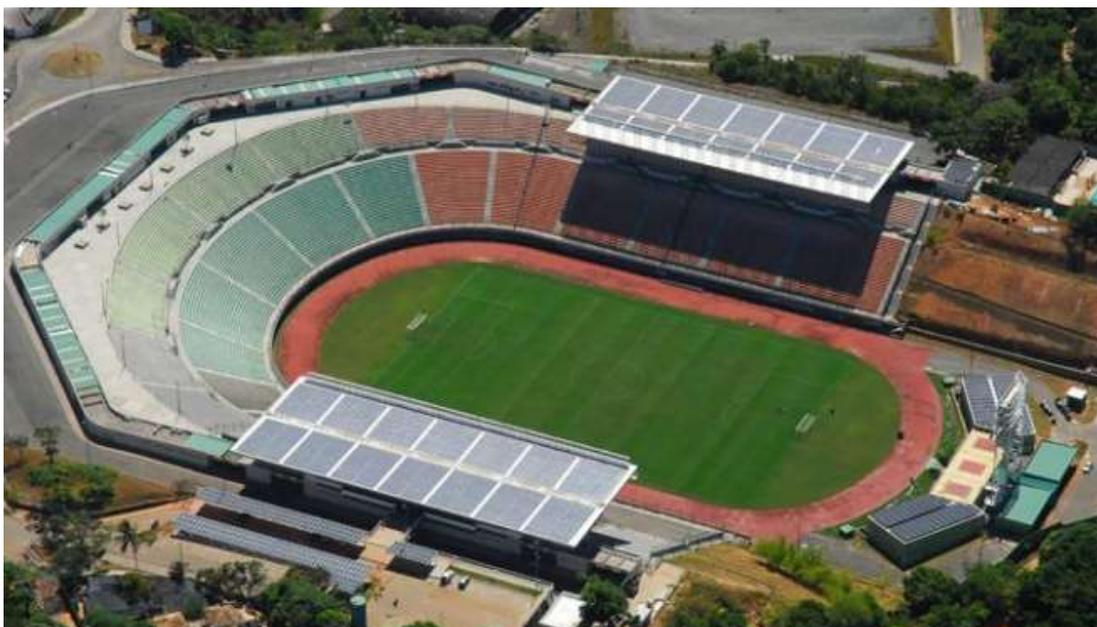
**Figura 4: Sistema fotovoltaico instalado no estádio Pituaçu, Bahia**
