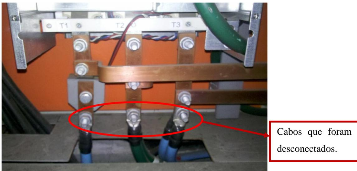
Figura 11 - Cabos de saída da chave de partida
