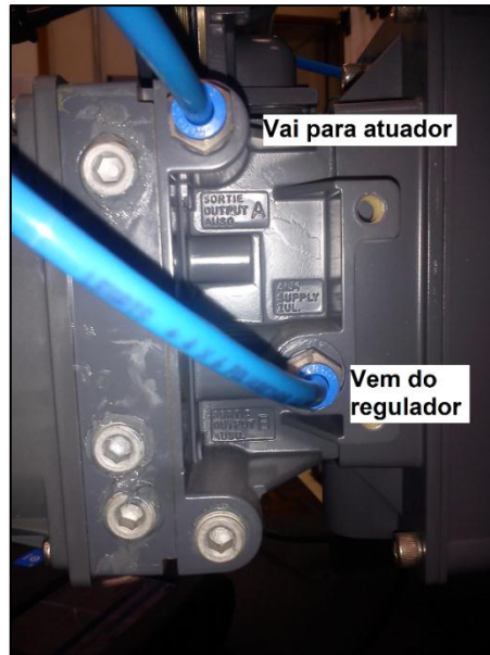
Figura 33 - Conexão pneumática do DVC 6200
