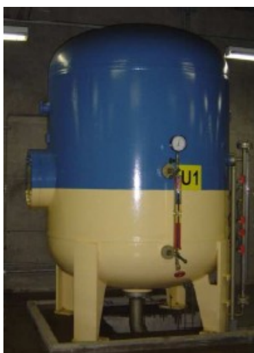
Figura 16 - Acumulador de ar e óleo. Fonte: Santiago, Becker e Kern (2004)
