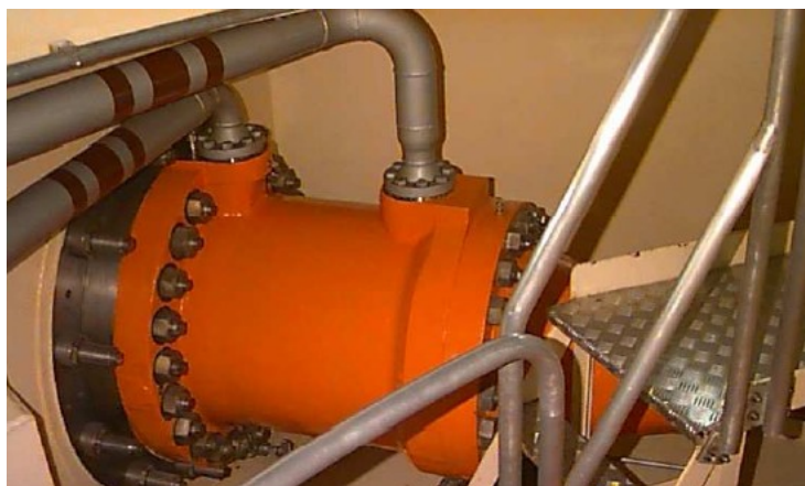
Figura 21 – Servomotor Fonte: Santiago, Becker e Kern (2004).
