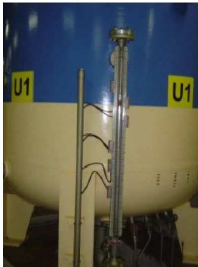
Figura 27 - Detalhe do controle de nível Fonte: Santiago, Becker e Kern (2004).
