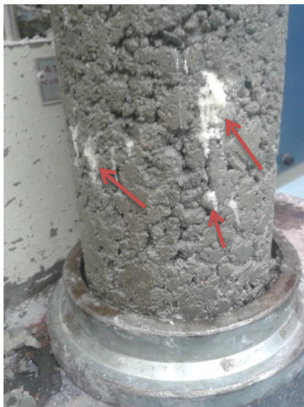
Figura 13 - Presença de cristais na superfície do concreto Fonte: Autoria Própria
