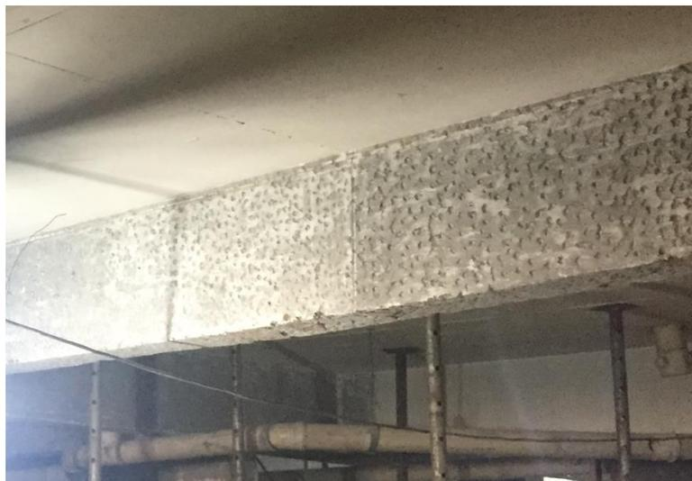
**Figura 6 - Preparação do substrato por apicoamento.**
