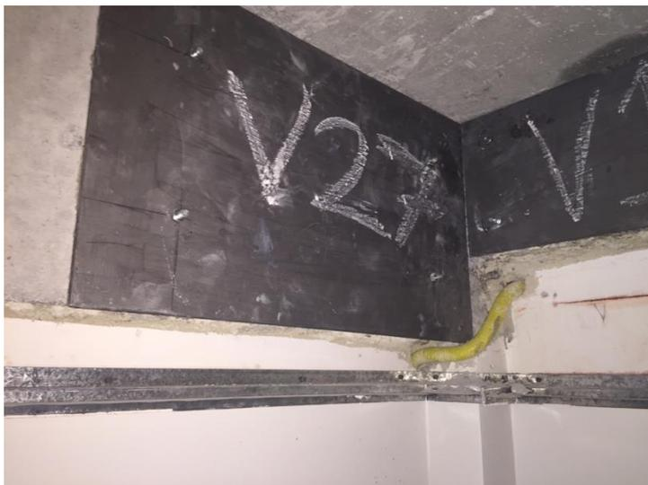
**Figura 12 - Fixação de chapa de aço com auxílio de chumbador.**
