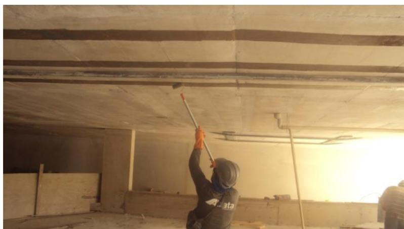
**Figura 14 - Aplicação do imprimador (Primer) com rolo.**
