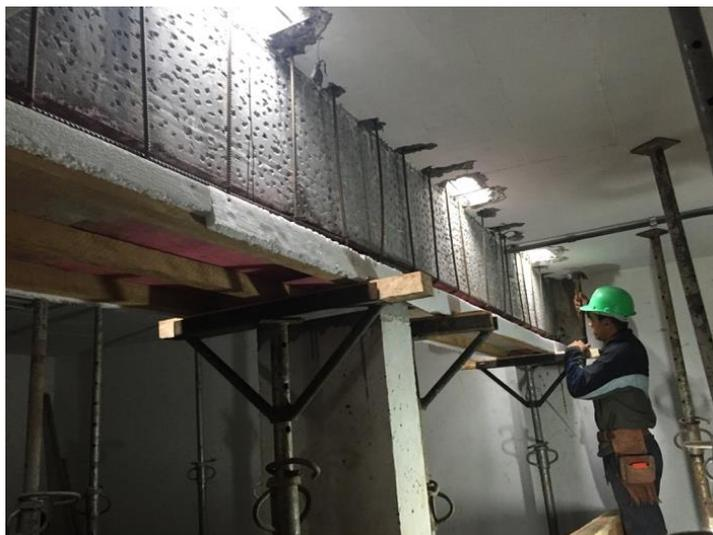
**Figura 8 - Preparação do sistema de fôrmas e escoramento.**
