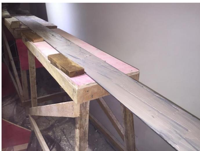
**Figura 11 - Aplicação de resina epóxi sobre a superfície da chapa.
