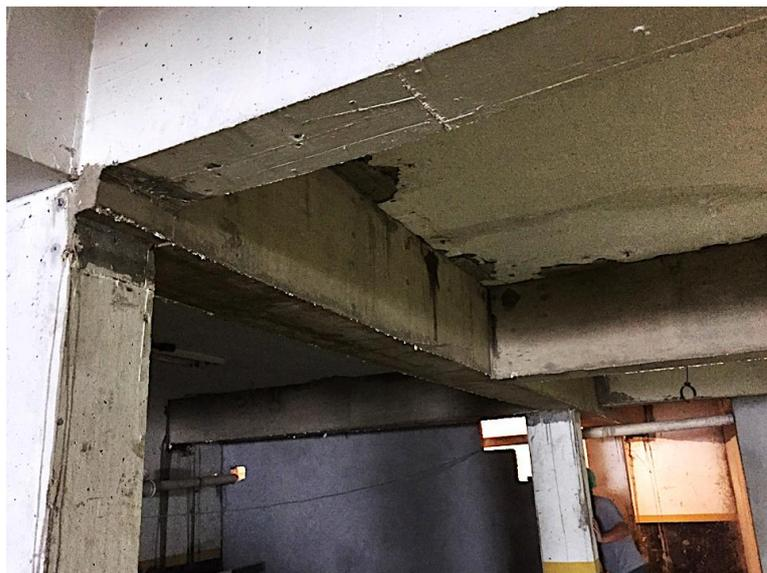
**Figura 9 - Resultado final de viga reforçada por encamisamento.
