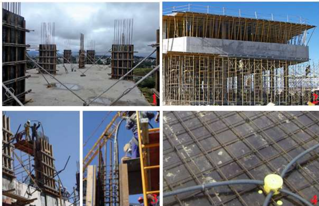
Figura 22 – Etapas 1 a 4 de construção de sistema em LLMA
