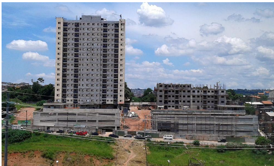
Figura 5 - Prédio de 20 andares de paredes de concreto em Barueri Fonte: Santos (2015).
