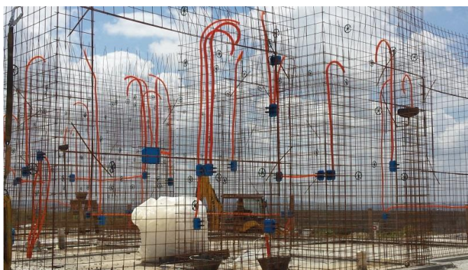
Figura 7 - Tubulações fixadas às armaduras Fonte: Meneses (2014).
