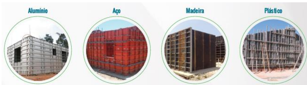
Figura 11 - Formas utilizadas nas paredes de concreto Fonte: ABCP (2014).
