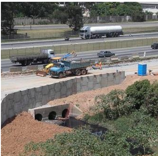
Figura 20: Exemplo de muro em área alagada Fonte: Muro Armado (2015).
