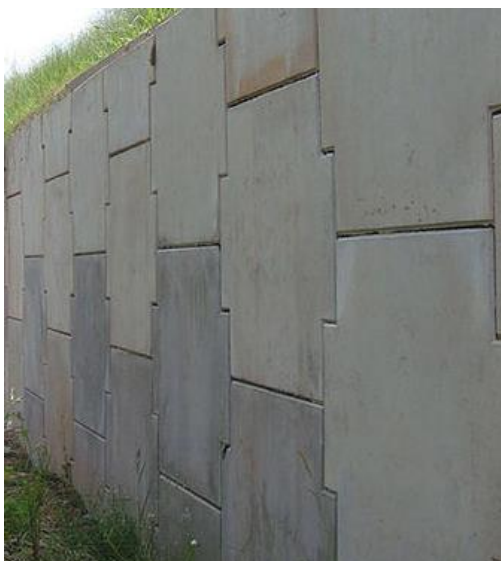
Figura 17: Exemplo de muro pé de talude Fonte: Muro Armado (2015).
