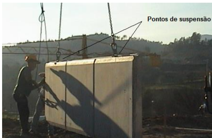
Figura 14: Exemplo de pontos de suspensão de um painel Fonte: Adaptado de FARCIMAR (2015).
