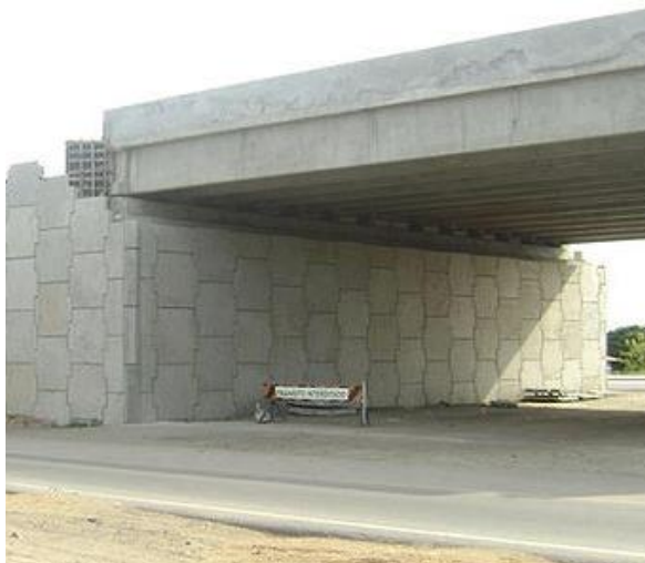
Figura 18: Exemplo de muro portante Fonte: Muro Armado (2015).
