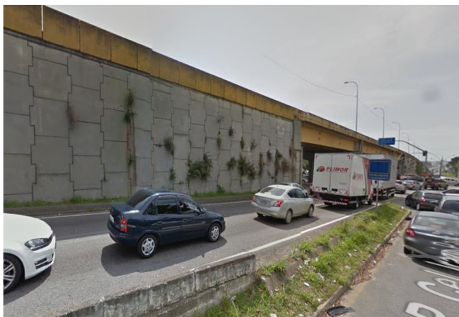
Figura 21: Viaduto da Avenida Victor Ferreira do Amaral - Curitiba, PR Fonte: GOOGLE MAPS (2015).
