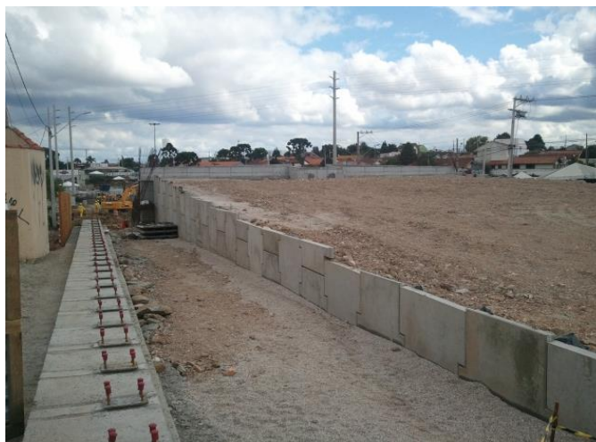
Figura 22: Construção das rampas de acesso em terra armada - Curitiba, PR
