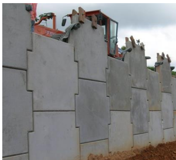
Figura 13: Painéis cruciformes Fonte: Terra Armada (2015).
