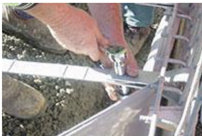
Figura 15: Fixação dos elementos de reforços (tiras metálicas) Fonte: Terre Armée (2014).
