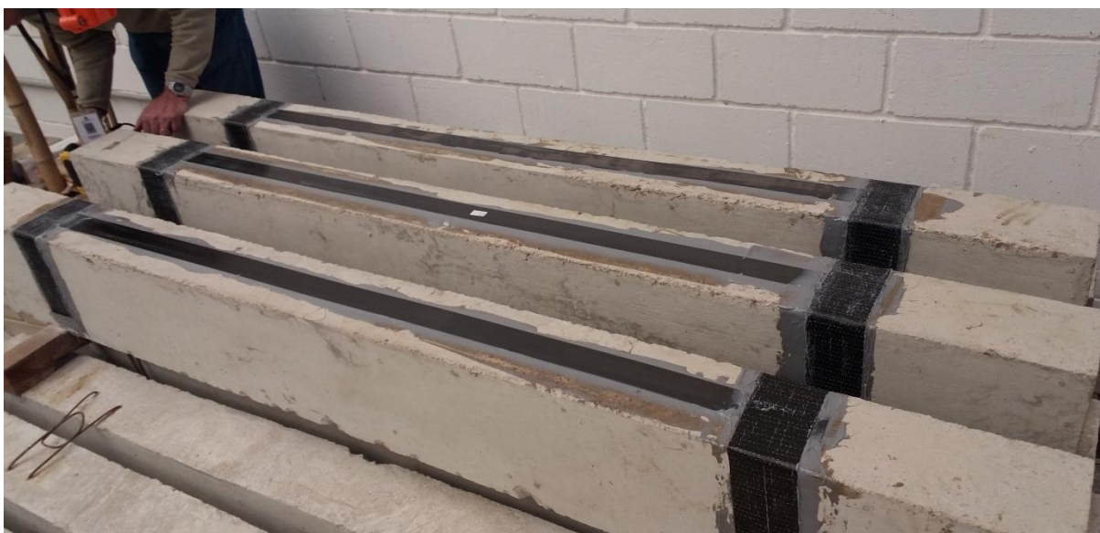
Figura 27 – Vigas do Grupo 3 após a execução do reforço Fonte: Autoria Própria.
