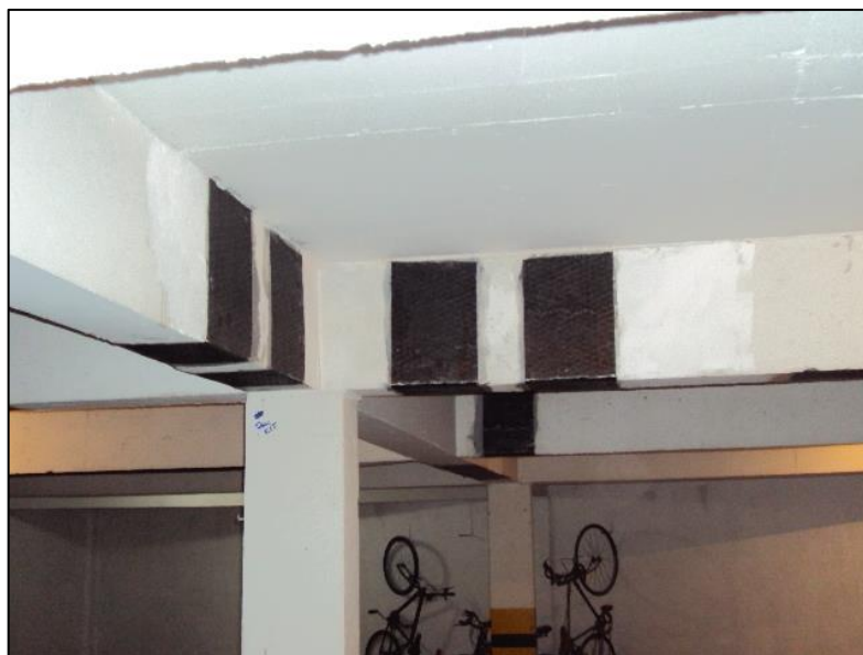
Figura 5 – Exemplo de aplicação de manta de fibra de carbono em reforço estrutural Fonte: Techniques (2016).
