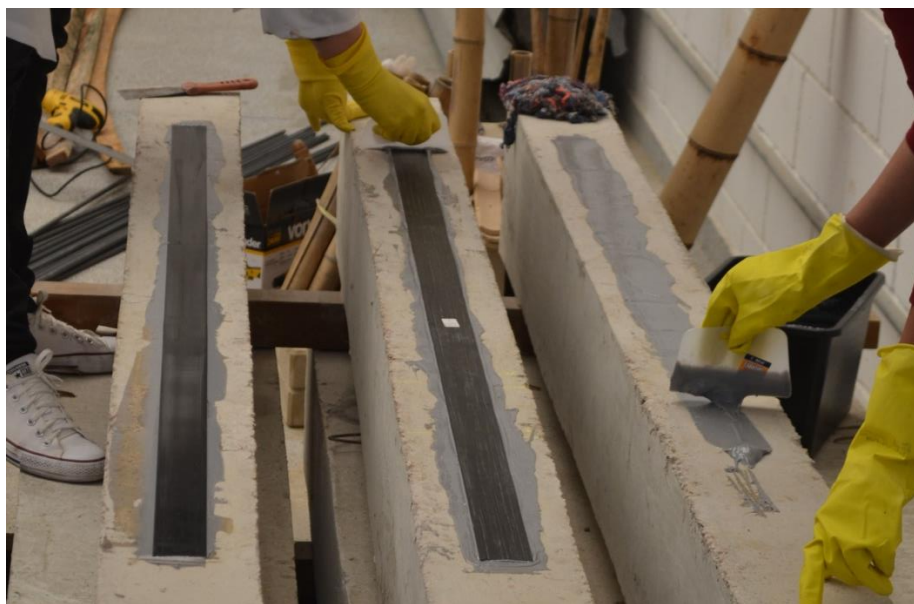
Figura 22 – Aplicação da resina epóxi e posicionamento das lâminas Fonte: Autoria Própria.
