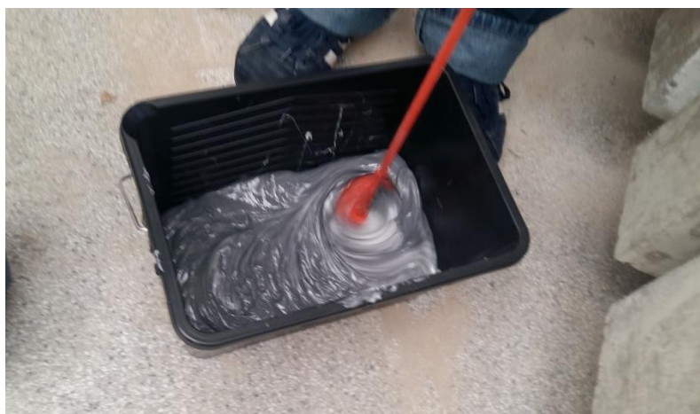
Figura 21 – Mistura dos componentes da resina epóxi
