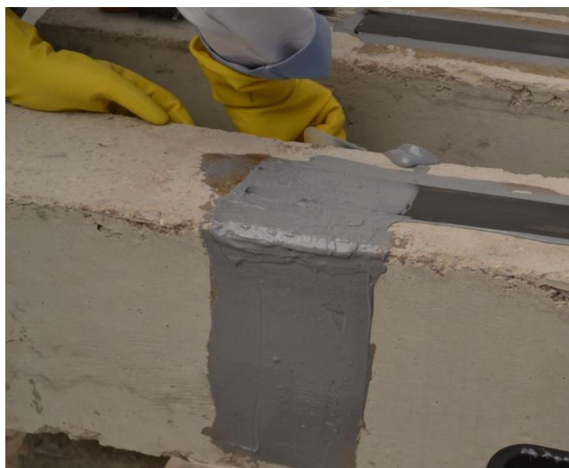
Figura 24 – Aplicação de resina epóxi na região do posicionamento da ancoragem Fonte: Autoria Própria.
