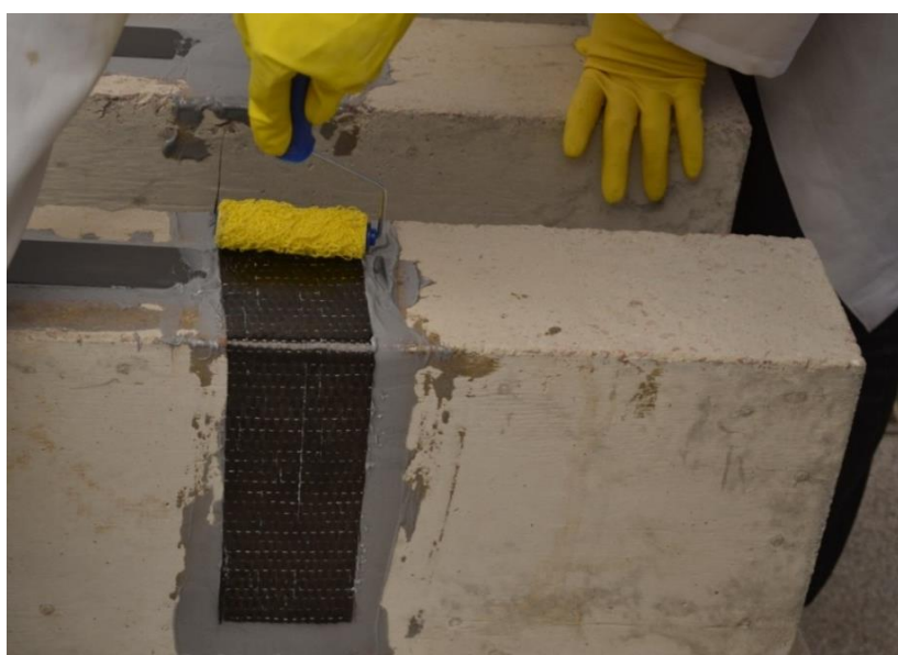
Figura 25 – Imprimação e retirada das possíveis bolhas de ar na interface manta-resina Fonte: Autoria Própria.
