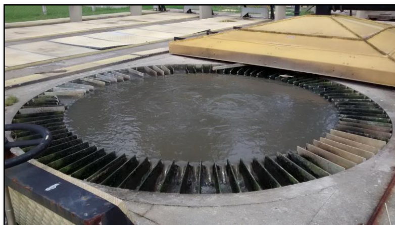
FIGURA 5 – Parte superior do reator, em que o efluente deixa o do reator.
