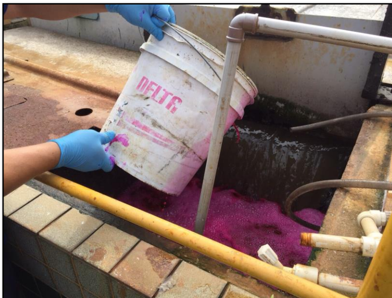
Figura 6 - Injeção de traçador na entrada do reator
