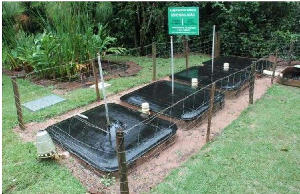
**Figura 3 - Fossa séptica biodigestor**
