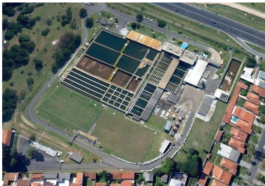
Figura 8 - Vista aérea ETA Iguaçu. Fonte: Google (2014).
