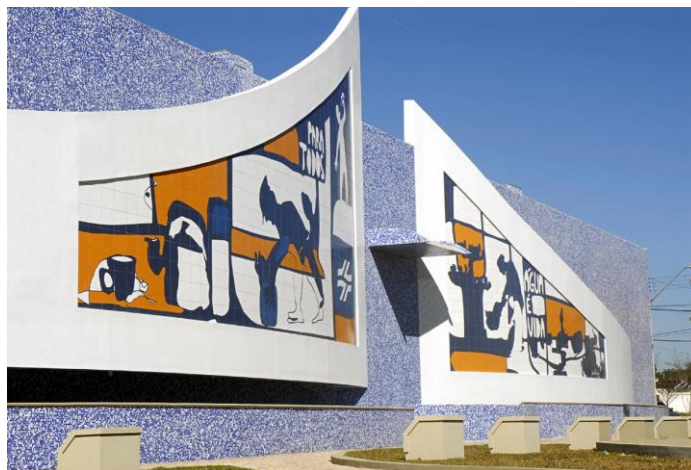
Figura 10 - Reservatório do Batel. Fonte: SANEPAR (2014b)
