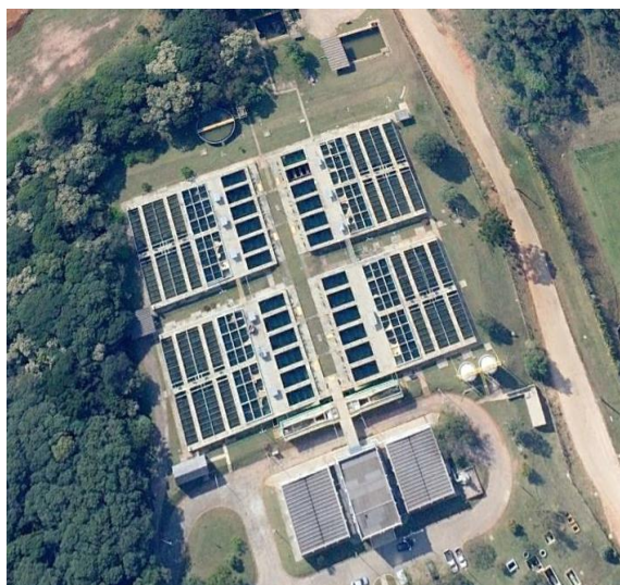
Figura 6 - Vista aérea da ETA Passaúna. Fonte: Google (2014).
