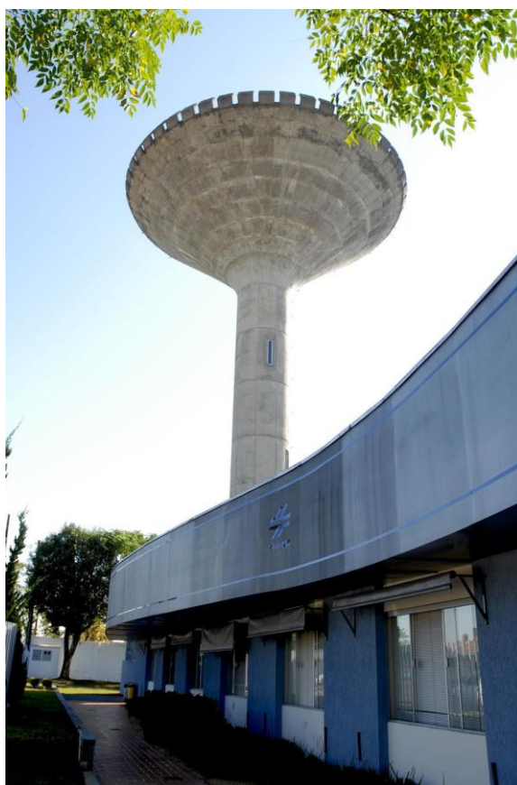
Figura 9 - Reservatório do Portão. Fonte: SANEPAR (2014b).
