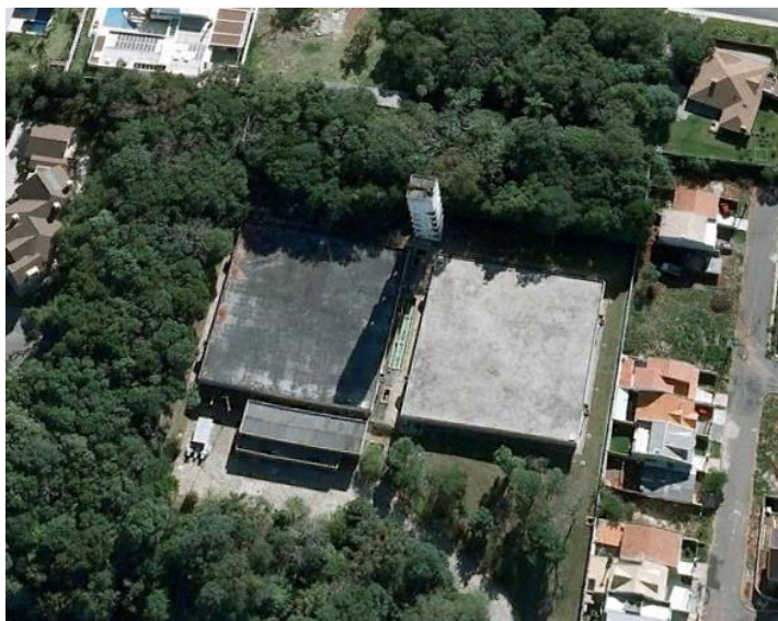
Figura 12 - Reservatório do Campo Comprido. Fonte: Google (2014).
