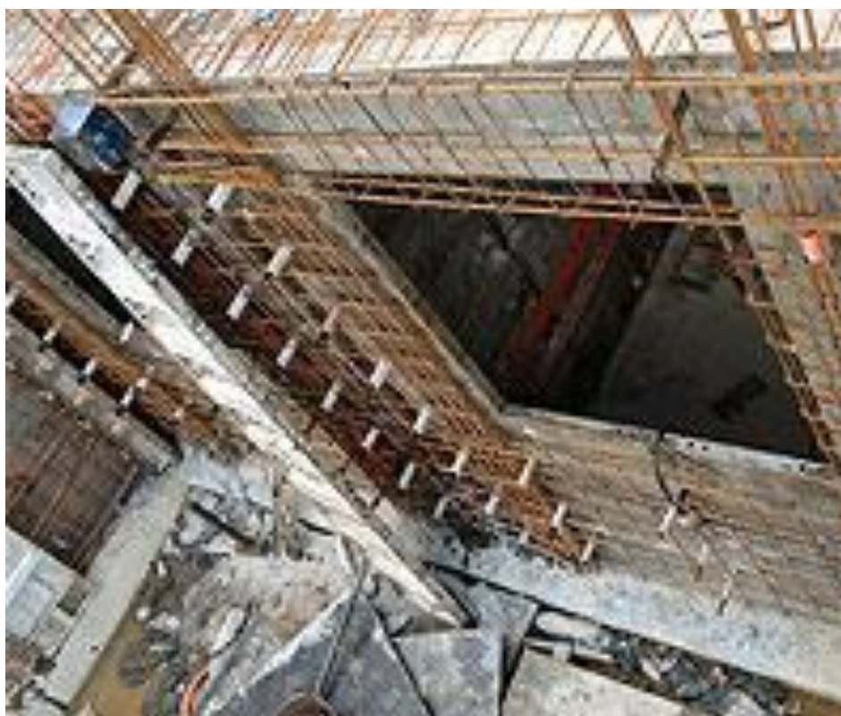
Figura 2 – Tela metálica montada, vãos recortados e reforços
