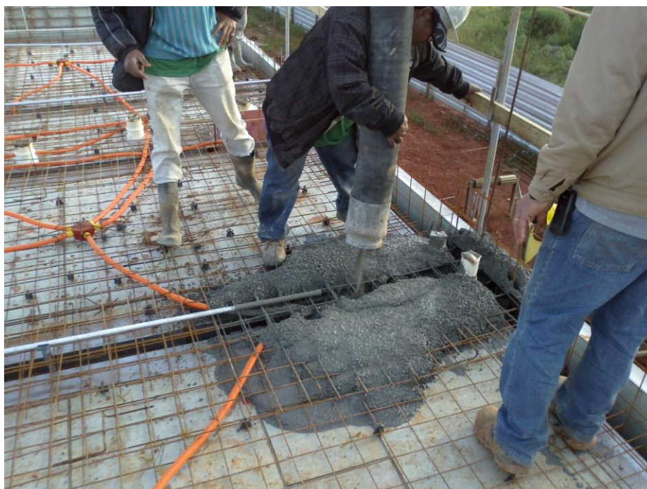
Figura 5 – Início concretagem das paredes
