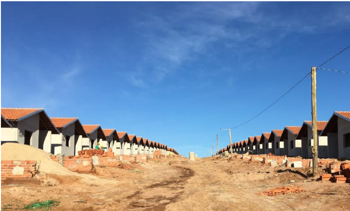
Figura 14 – Obra na fase de acabamento sem infraestrutura.
