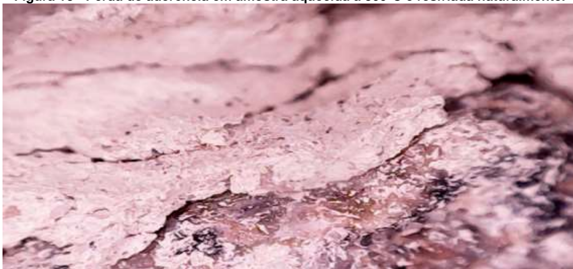
Figura 18 - Perda de aderência em amostra aquecida a 800°C e resfriada naturalmente.
